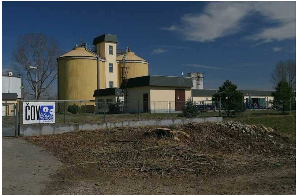
Příloha 8 Obrázek č. 1 ČOV Strakonice - vjezd do areálu ČOV je dokončen
