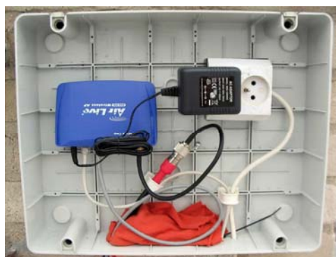
Obrázek 6 - použité montážní krabice GEWISS-GW44210 u klienta
