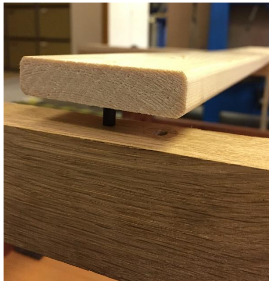
Obr. 11 Detail uchycení latí pomocí upínacího elementu
