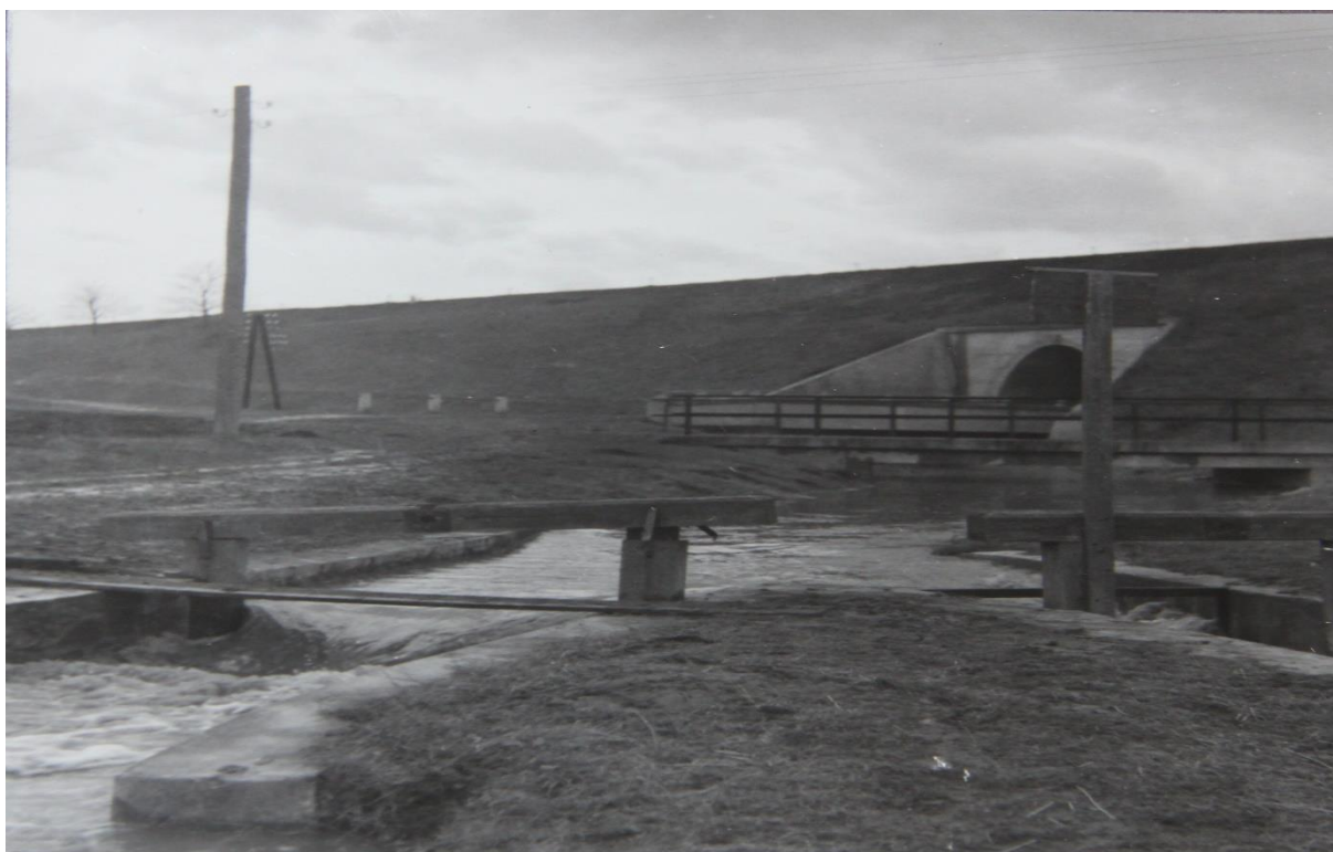
Foto. 2.3 Dobová fotografie vtokového objektu nádrže Jandovka
