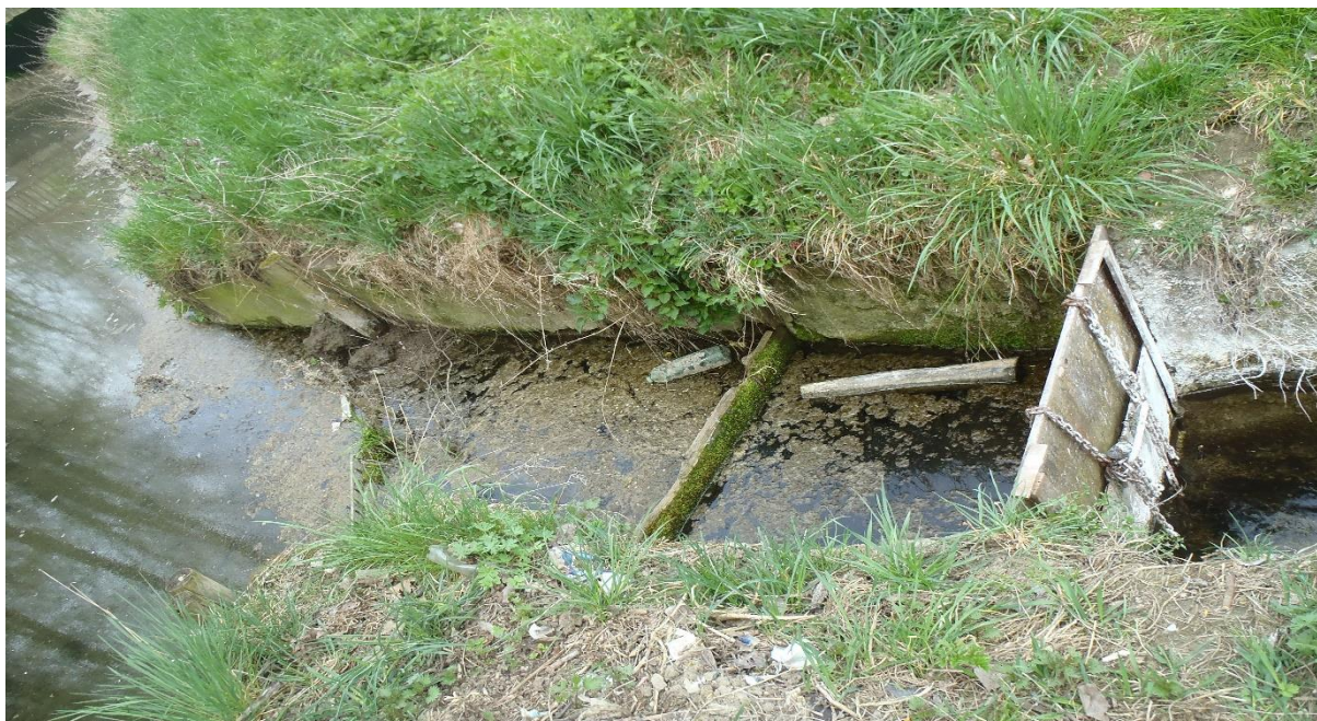
Foto. 5.1 Vtokový objekt nádrže Jandovka
