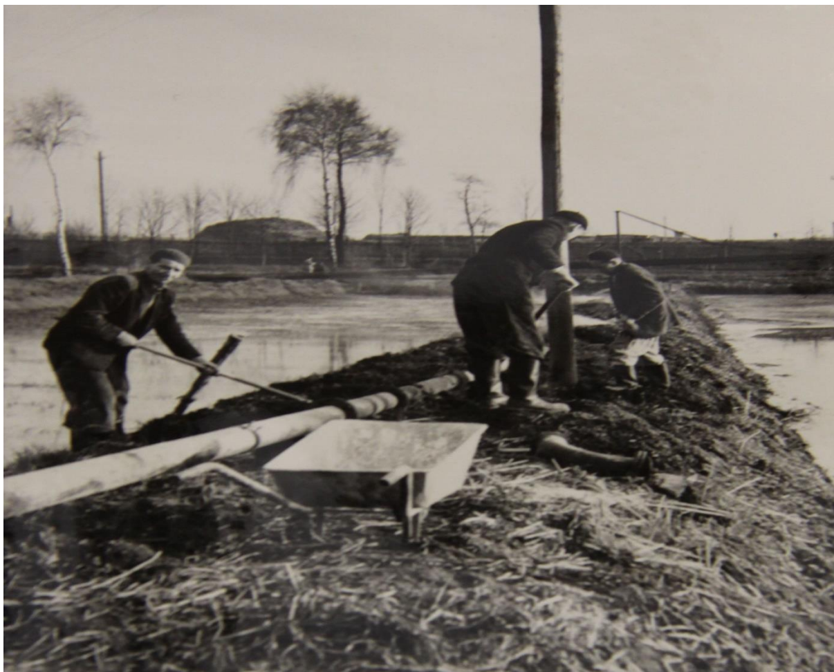
Foto. 2.2 Dobová fotografie stavby hráze mezi sedimentačními nádržemi
