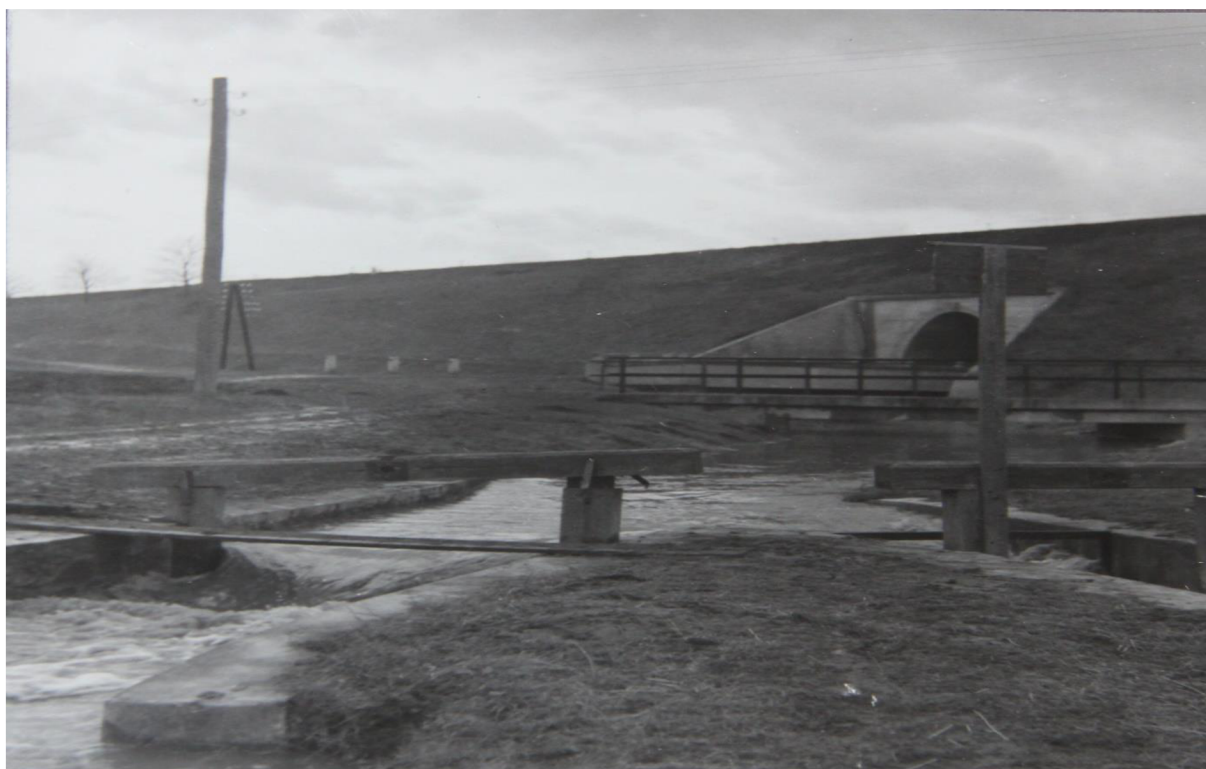
Foto. 2.3 Dobová fotografie vtokového objektu nádrže Jandovka
