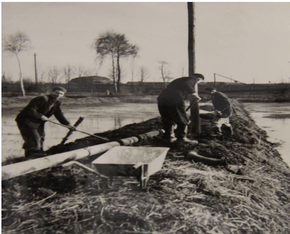
Foto. 2.2 Dobová fotografie stavby hráze mezi sedimentačními nádržemi
