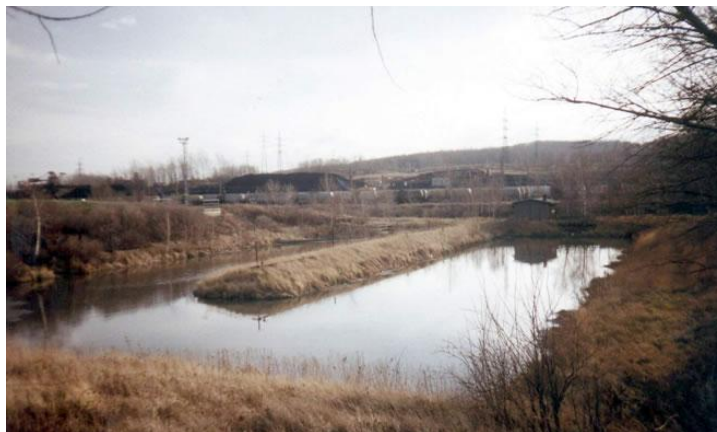
Obr. č. 14 Usazovací nádrž č. 4 (Čištění odpadních vod v Chemopetrol, a.s., 2003)
