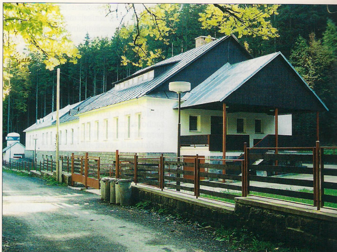
Úprava vody v Karlově
