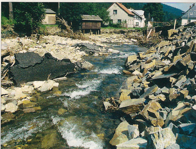
Velké škody napáchala řeka Bílá Opava při povodni v roce 1997 v obci Ludvíkov
