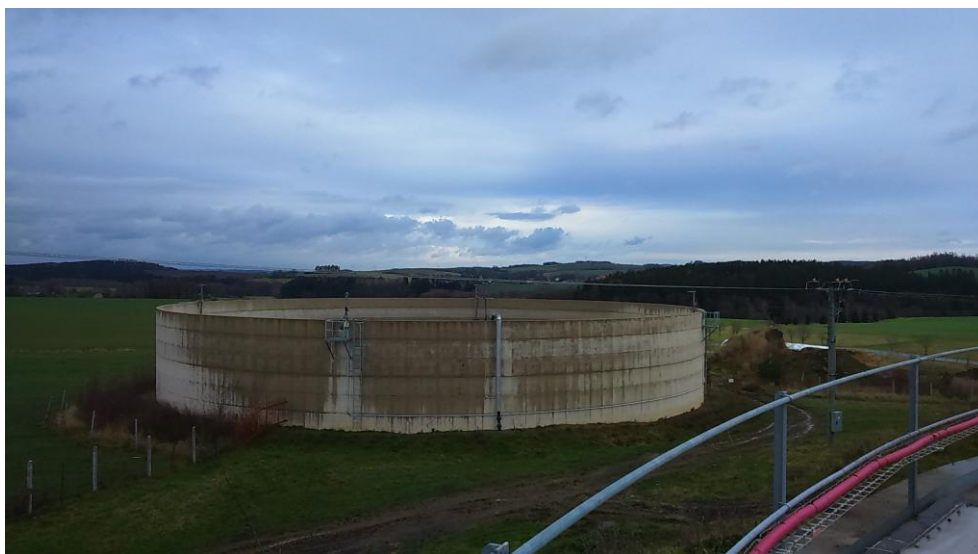
Obrázek č. 17: Jímka na kontaminované vody a sklad digestátu
