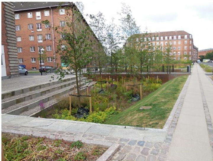
Obr. 6.2: Suchá retenčná nádrž (polder) [31]
