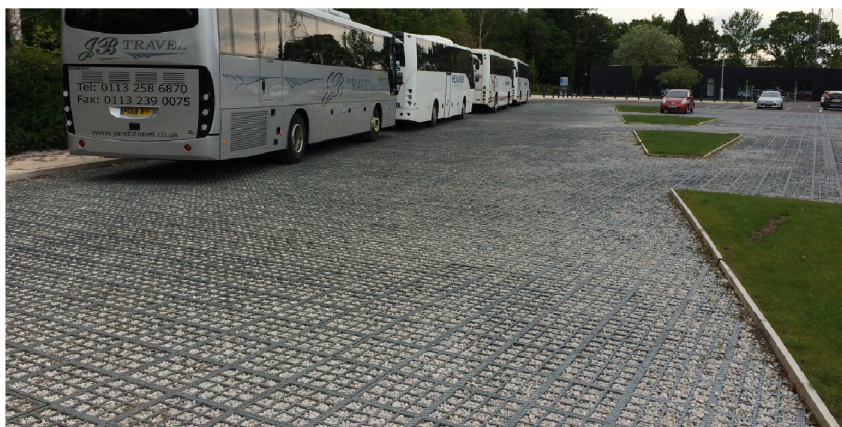
Obr. 6.10: Zasakovací rošt TTE od firmy Geosynthetics [37]
