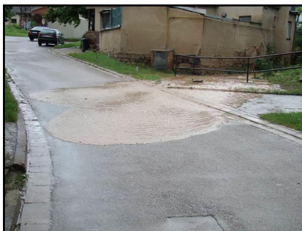
Obrázky 12: Nekapacitní propustek DN 800 (zdroj: autorka, 2015)
