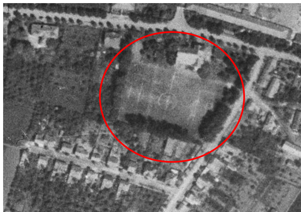
Obr. 34 Fotbalové hřiště na leteckém snímku z roku 1954 (VGHMÚř Dobruška, © MO ČR 2009)
