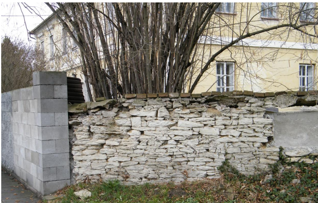
Obr. 17 Detail opukové zídky u fary v kontrastu s novodobým materiálem (Petrovická, 2015)
