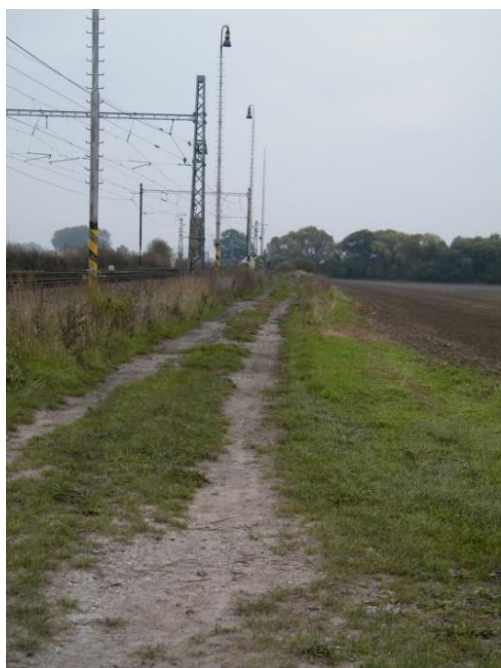
Obr. 14 Trakční vedení dráhy v krajině Kostomlat, pohled směrem od obce k Nymburku (K. Petrovická, 2014)
