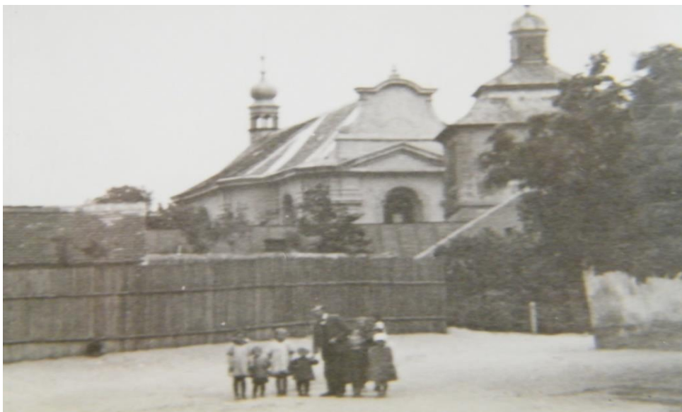
Obr. 20 Kostel sv. Bartoloměje a zvonice na dobové fotografii (SOkA Lysá n. L.; foto: Petrovická, 2015)
