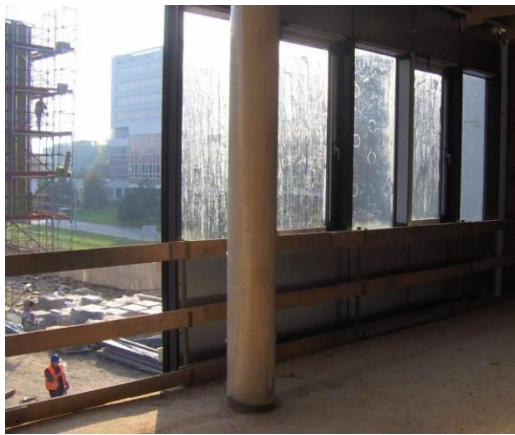
Obrázek č. 162 - Osazování obvodového pláště [29]
