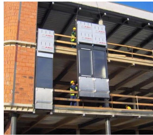
Obrázek č. 161 - Osazování obvodového pláště z jeřábu [29]
