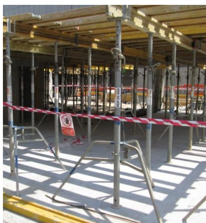
Obrázek č. 175 - Bednění stropů [29]
