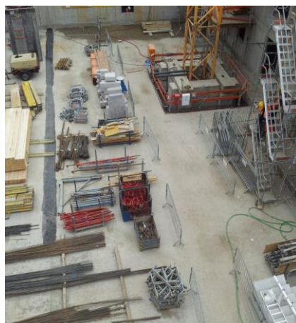
Obrázek č. 136 - Skladovací plochy [29]
