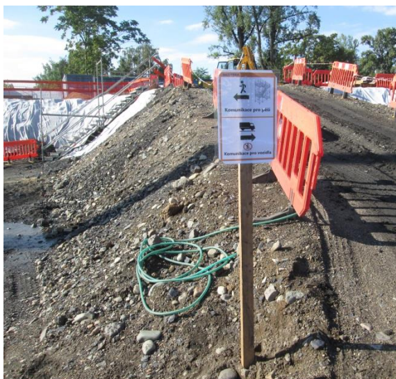
Obrázek č. 148 - Přístup do stavební jámy [29]
