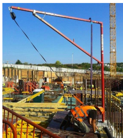
Obrázek č. 176 - Bednění stropů – pohled [29]
