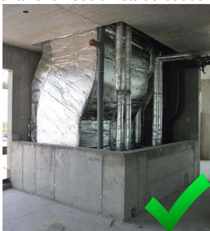
Obrázek č. 158 - Instalace rozvodů – dobře [29]
