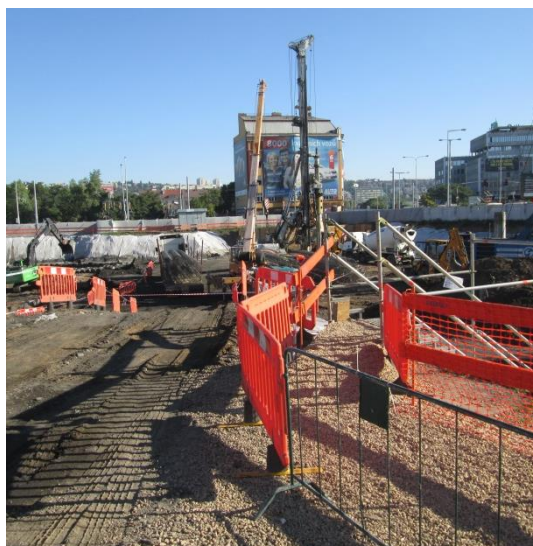
Obrázek č. 149 - Přístup do stavební jámy – ohrazen [29]
