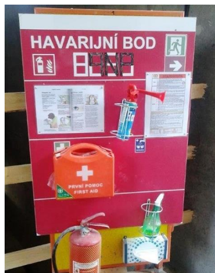
Obrázek č. 143 - Havarijní bod [29]
