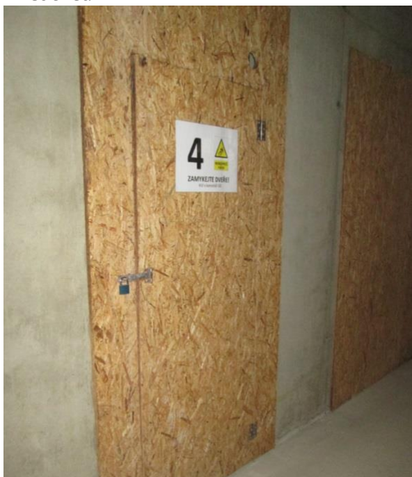
Obrázek č. 163 - Výtahové šachty [29]
