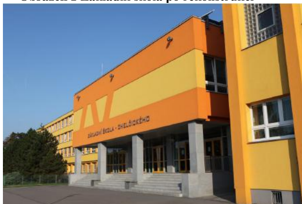
Obrázek 1 Základní škola po rekonstrukci
