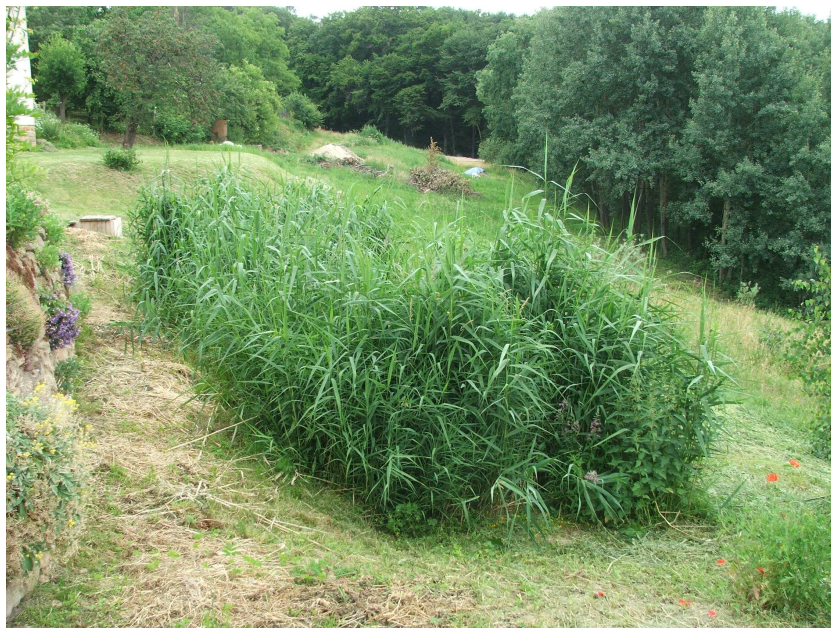
Fotografie 1: Přírodní čistírna odpadních vod u rodinného domu v Kostelci nad Černými lesy (4 EO, 350 m n. m., v provozu od roku 1996, osázená rákosem, stav po pětiletém provozu) (68, 80)
