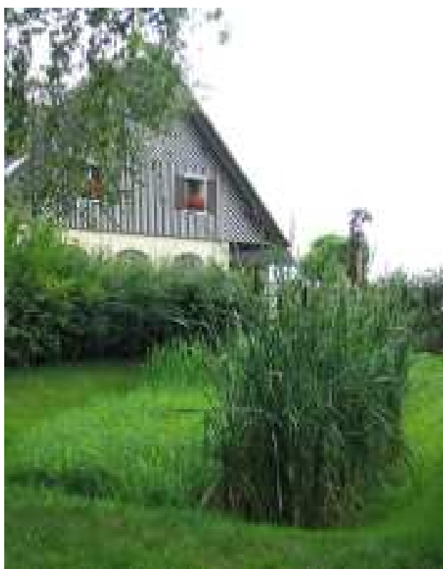
Fotografie 4: Přírodní čistírna odpadních vod v Bohuslavi u Hrubé Skály pro 4 obyvatele (25m 2 , v provozu od roku 1996, stav po devítiletém provozu) (100)
