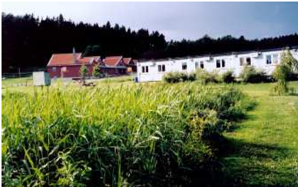
Fotografie 6: Přírodní čistírna odpadních vod u školního kampusu v Björkö ve Švédsku (septik, kořenové pole s podpovrchovým horizontálním průtokem, dočišťovací rybníček) (100)
