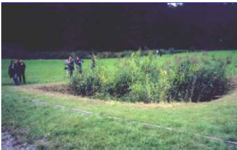
Fotografie 7: Přírodní čistička pro zemědělskou farmu v Rakousku v nadmořské výšce 1633 m (pro 8 EO, osázeno rákosem, 40m 2 ) (100)
