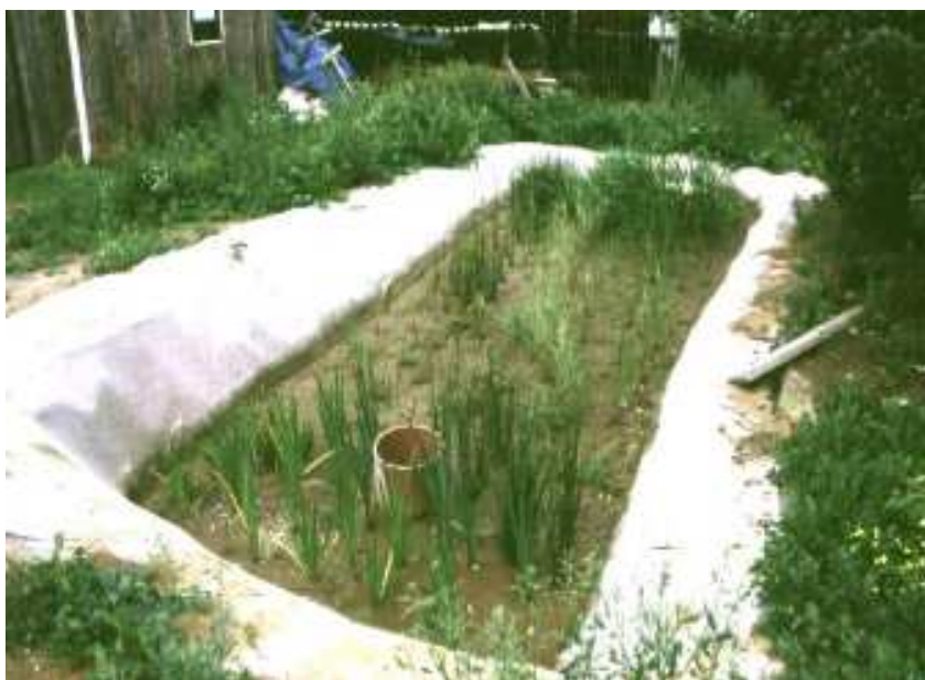
Fotografie 3: Nově osázená domovní kořenová čistírna odpadních vod v Kyjově u Havlíčkova Brodu pro 4 osoby (25m 2 ) (100)
