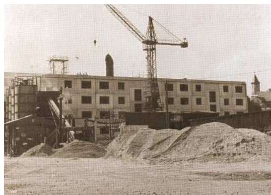
Obr 4: Výstavba sídliště Antonína Zápotockého v Zábřehu Zdroj: Zábřeh – 750 let. Bartoš et al., 2004.
