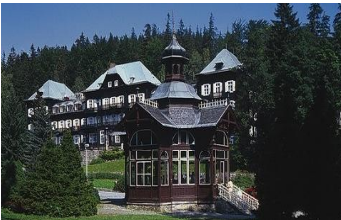
Příloha č. 3 – Ukázka unikátní lázeňské architektury
