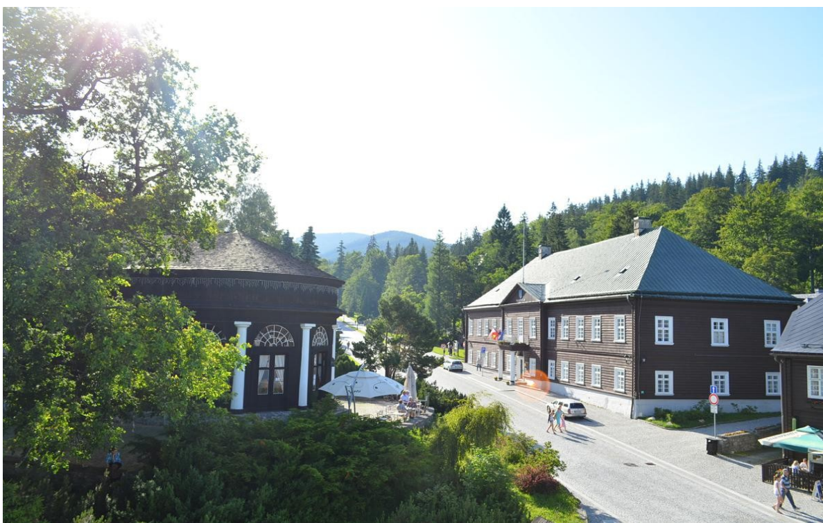
Příloha č. 4 – Ukázka unikátní lázeňské architektury 2
