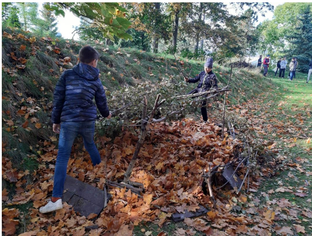
Obrázek 20 - Dokončená stavba bunkru (21.11.2022, Školní zahrada)
