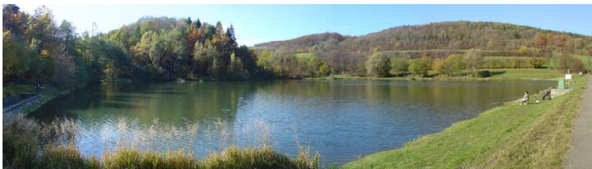
Obr. 39 Malá vodní nádrž Čerták na Kojetínském potoce u Nového Jičína
