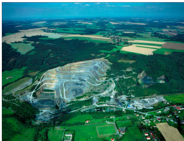
Obr. 98 Ložisko stavebního kamene Jakubčovice a kamenolom
