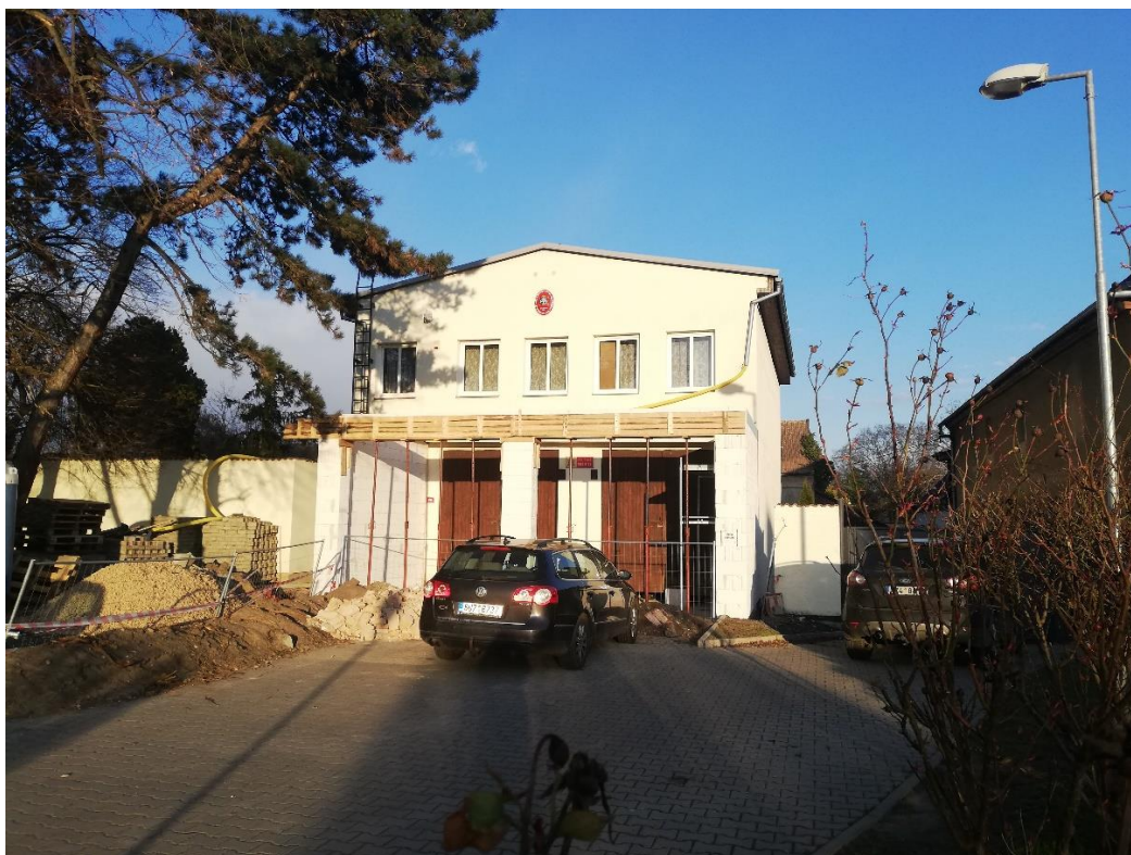
Obrázek 13 Budova hasičské zbrojnice
