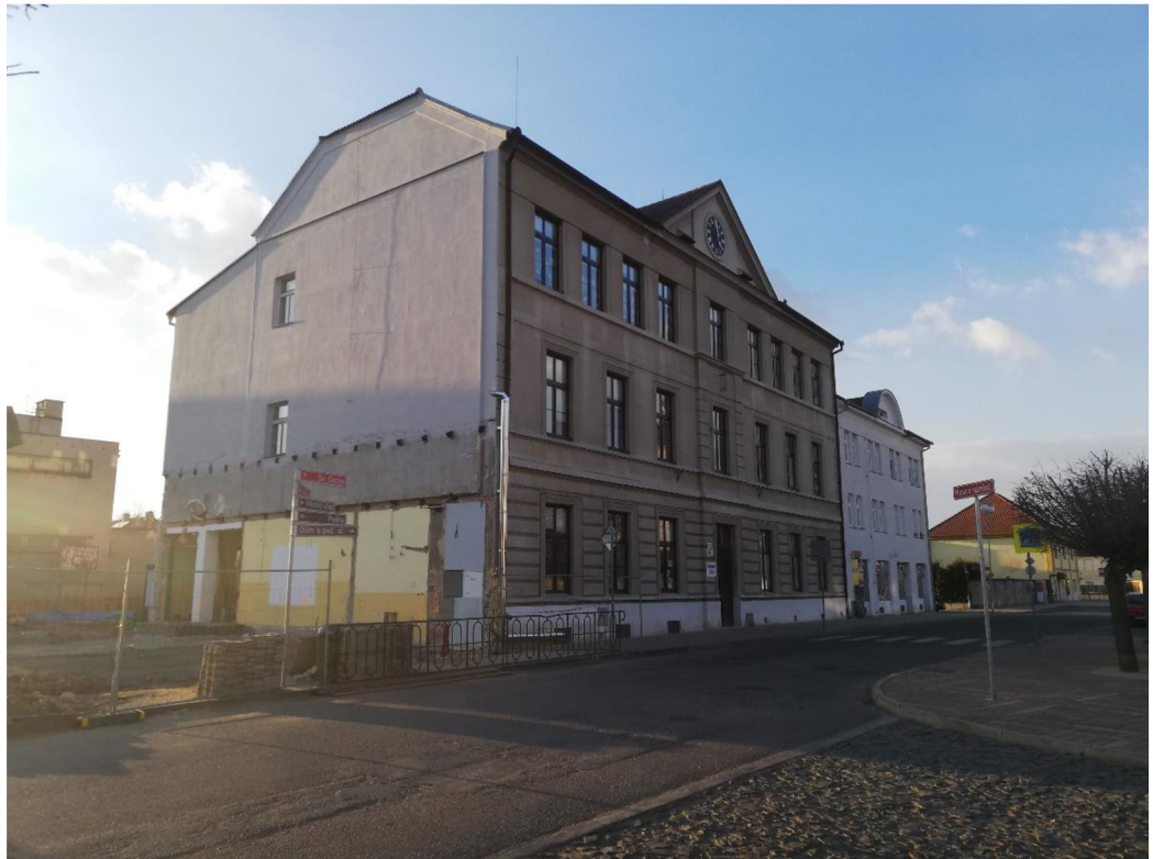
Obrázek 8 Přístavba ZŠ Bohušovice
