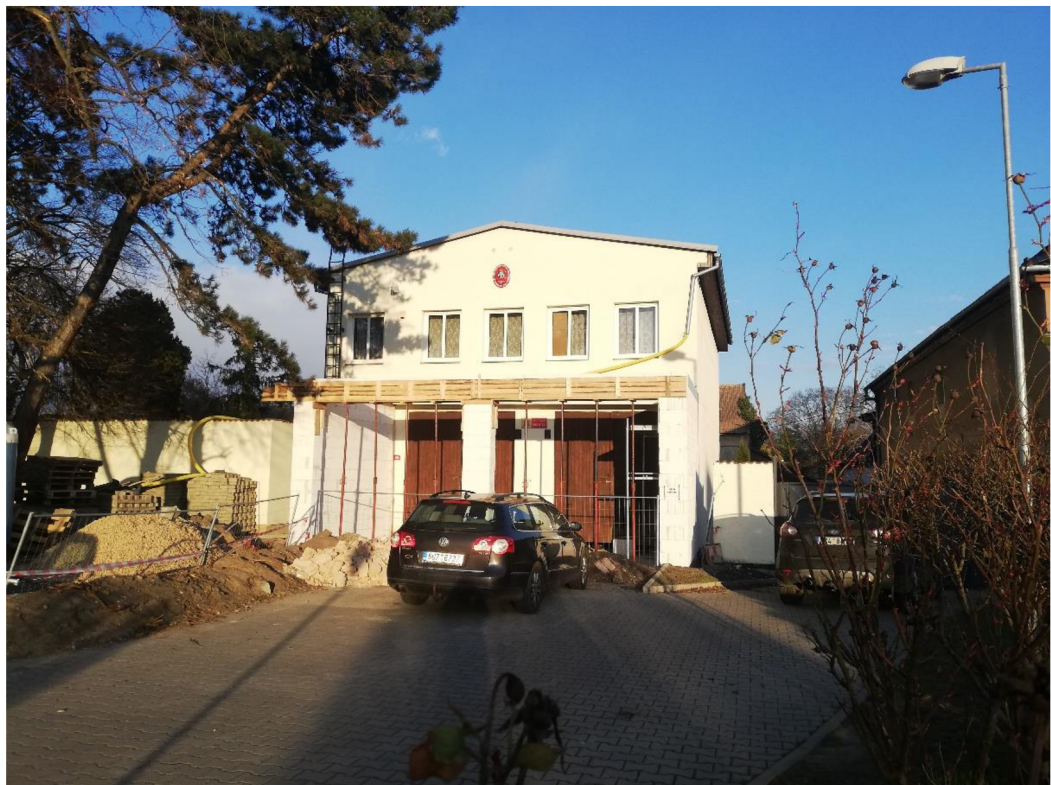
Obrázek 13 Budova hasičské zbrojnice
