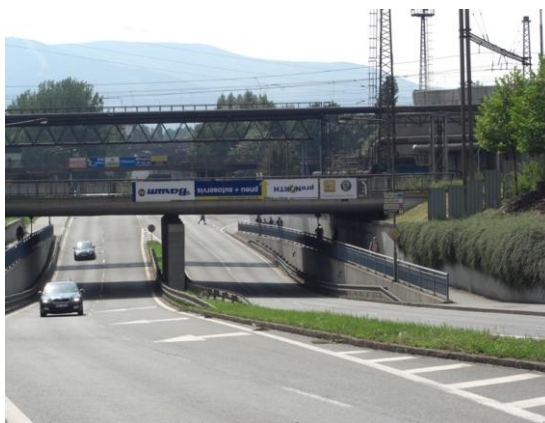
Obr. 9 Silnice II/468 po rekonstrukci; komunikační průkop „Myší díra“
