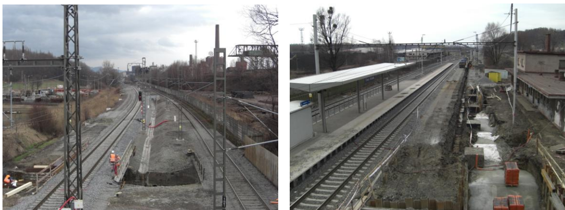
Obr. 19, 20 Modernizace železniční trati a rekonstrukce zastávky Třinec – Konská v rámci projektu Optimalizace trati Bystřice nad Olší - Český Těšín
