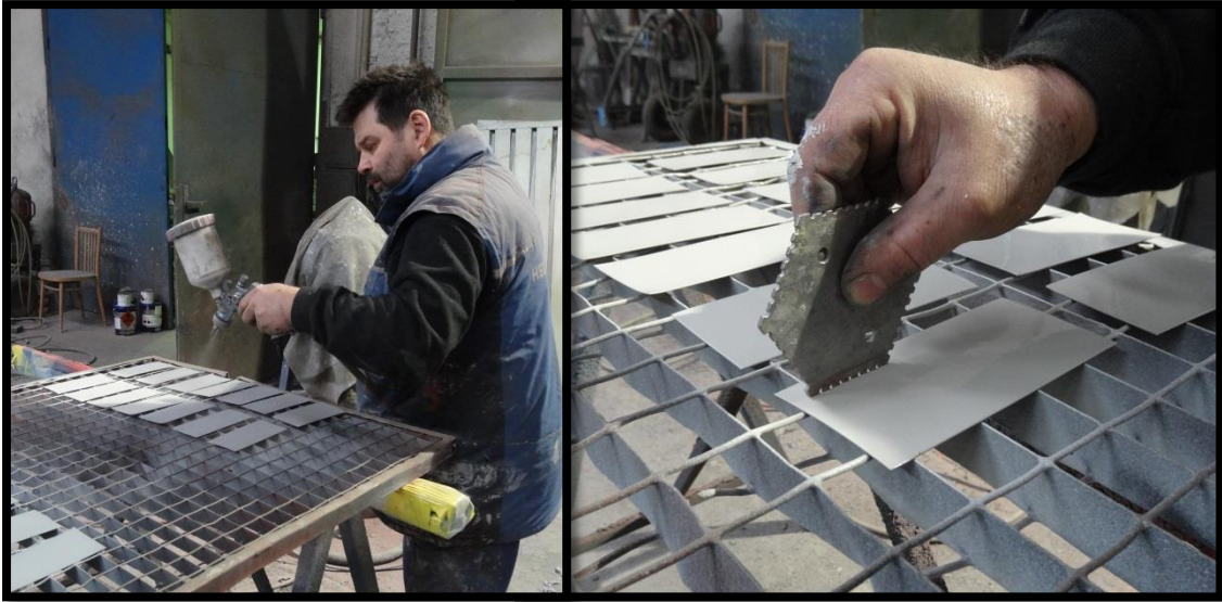
Obr. 30 - Aplikace syntetického nátěru a měření tloušťky mokrého nátěru (Zdroj: Vlastní zpracování)
