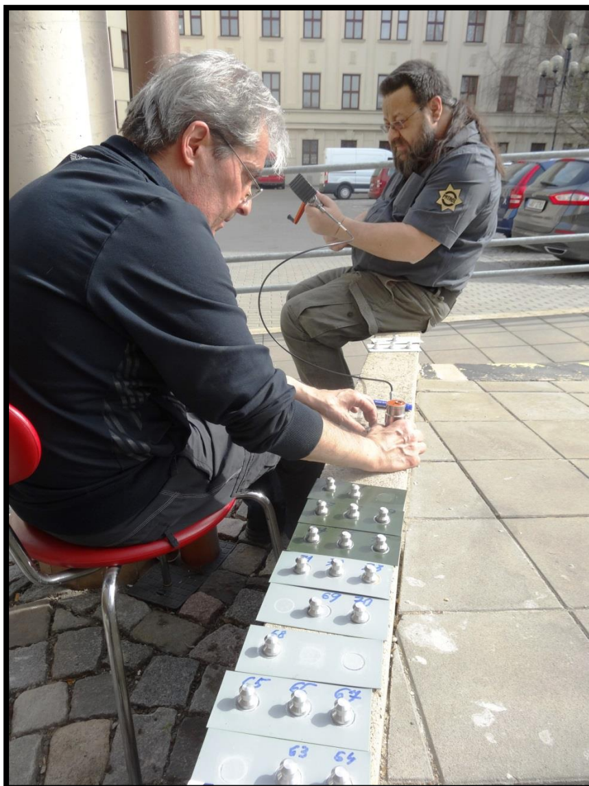
Obr. 51 - Provádění odtrhových zkoušek ve venkovních podmínkách (Zdroj: Vlastní zpracování)
