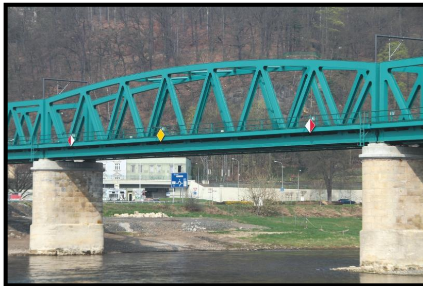
Obr. 16 - Mostní konstrukce, protikorozní ochrana nátěrem (Zdroj: www.silnice-zeleznice.cz )
