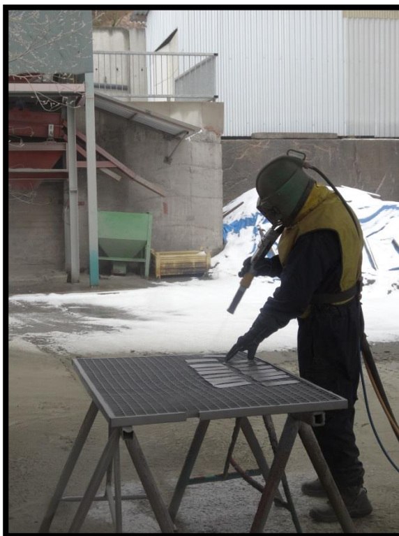
Obr. 26 - Samotné tryskání (Zdroj: Vlastní zpracování)
