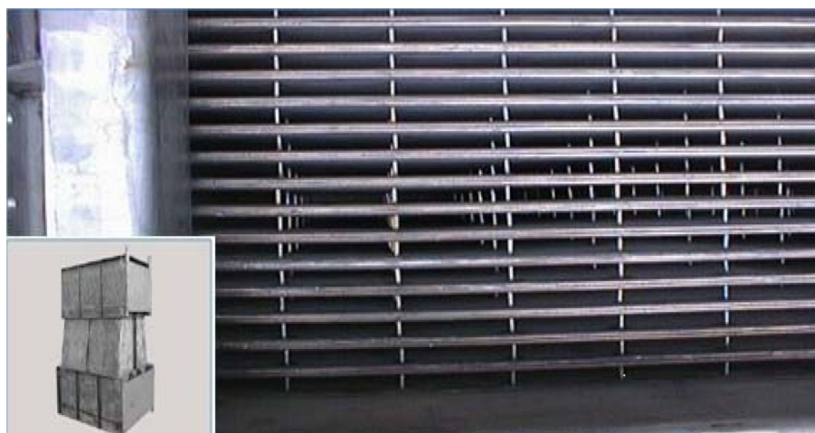
Obr. 2.8 Deskový výměník tepla s hladkými deskami [11].
