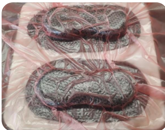
Obr. 24 Položení separační vrstvy.
