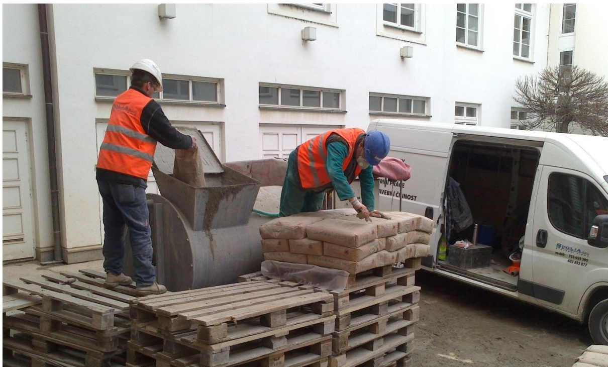
Obr. 18 Ruční dávkování cementu do výrobního zařízení SIRCONTEC MS 1000
