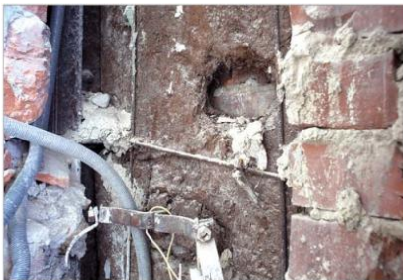
Obr. 13 Vila Tugendhat: detail izolace značky Torfoleum u ocelového nosného sloupu (vlevo).
