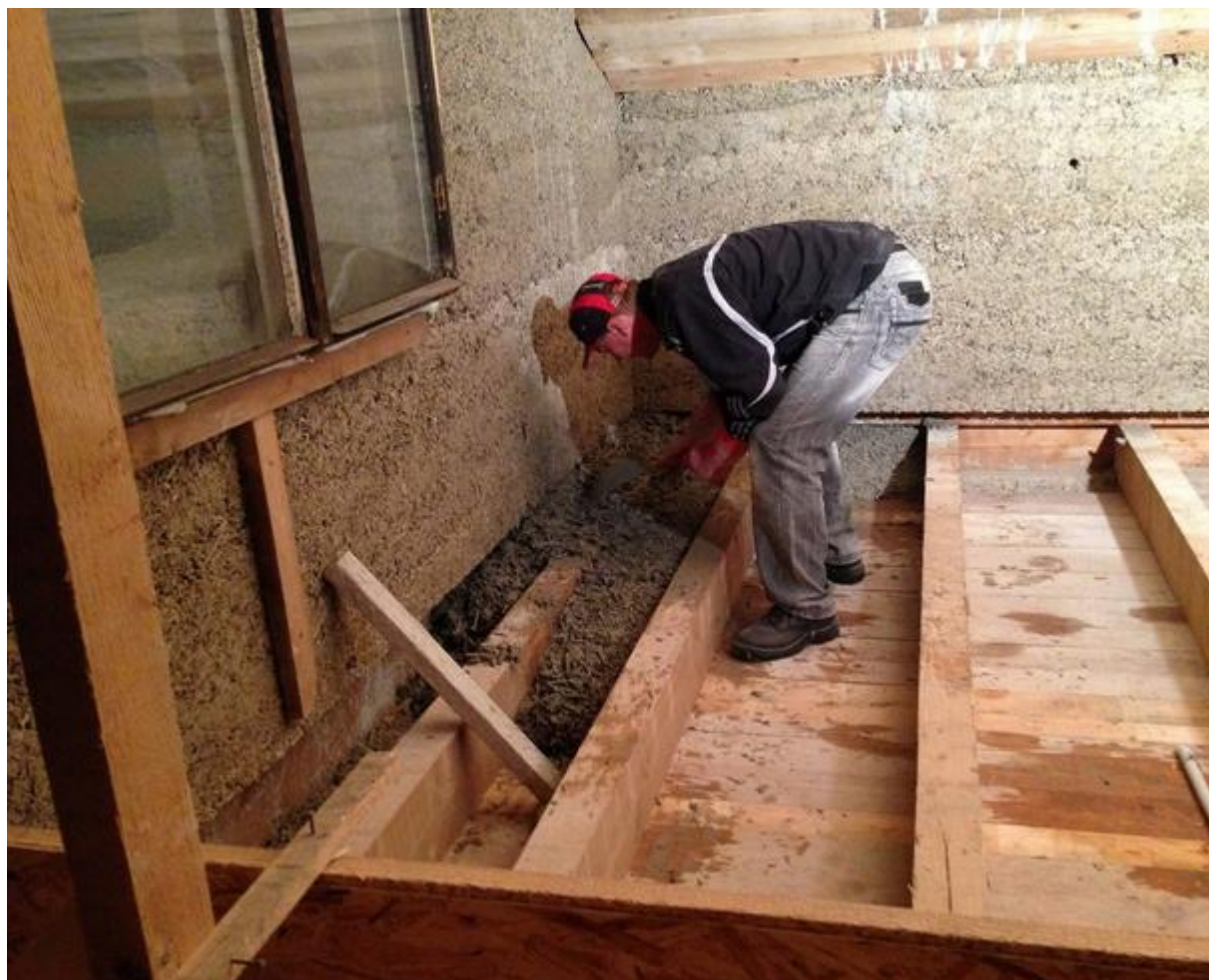
Obr. 9 Ve směsi na podlahu je pazdeří nejméně
