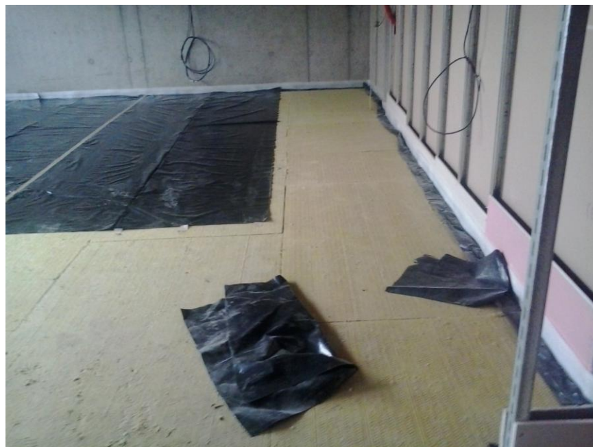
Obr. 28 Názorná ukázka Varianty 2, pokládka skelné vaty Isover TDPT, separační Pe - folie a obvodového mirelonového pásu na stropní konstrukci
