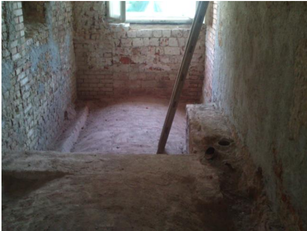
Obr. 32 Ukázky z rekonstrukce objektu v Praze Pohoželci
