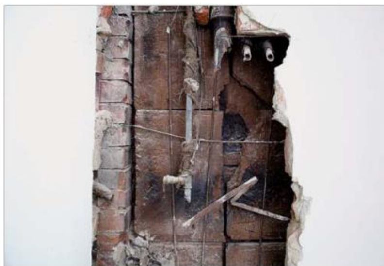
Obr. 12 Vila Tugendhat: izolační desky značky Torfoleum ve zdivu v někdejším pokoji kuchařky v personálním traktu (2. NP).
