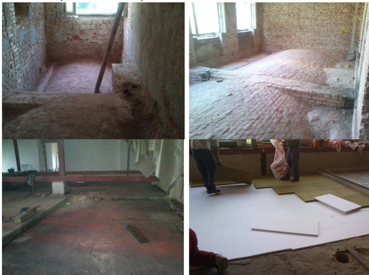
Obr. 32 Ukázky z rekonstrukce objektu v Praze Pohořelci
