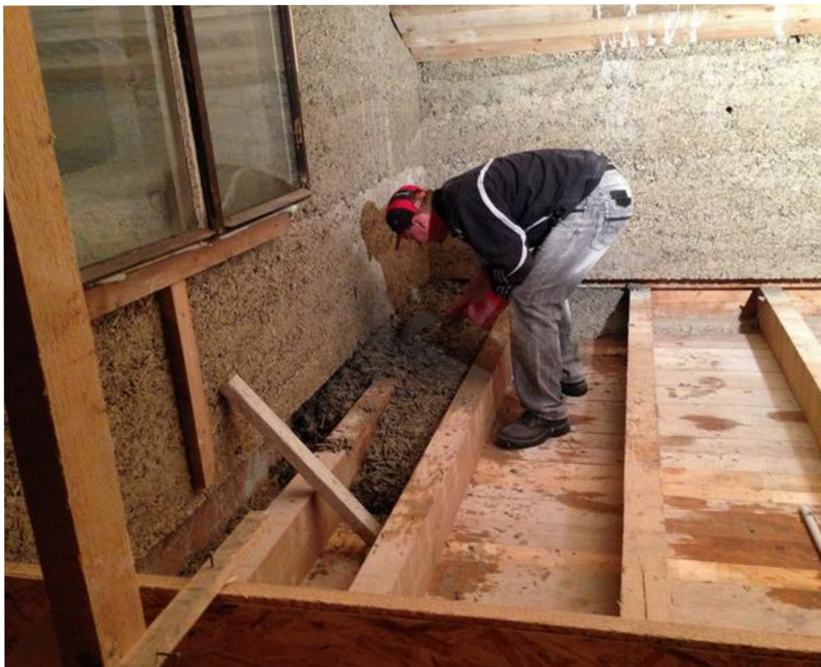
Obr. 9 Ve směsi na podlahu je pazdeří nejméně
