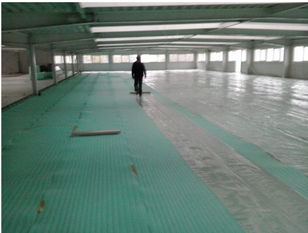
Obr. 47 Názorná ukázka Varianty 3, pokládka Ethafoamu a separační Pe - folie na stropě výrobní haly
