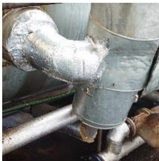
Obrázek 34: Opravená izolace potrubí
