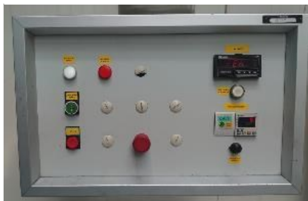
Obrázek 14: Opravený panel stroje
