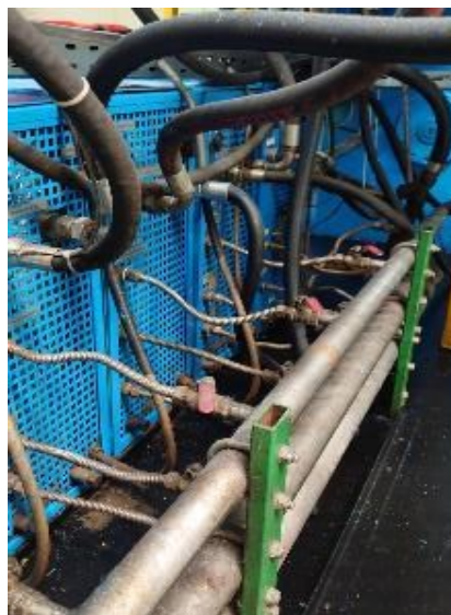
Obrázek 10: Srovnání kabelů + protikorozní povlak na topných zařízeních
