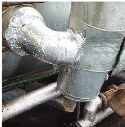
Obrázek 34: Opravená izolace potrubí
