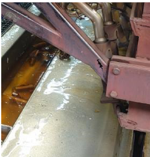
Obrázek 29: Prasklina na vozíku
