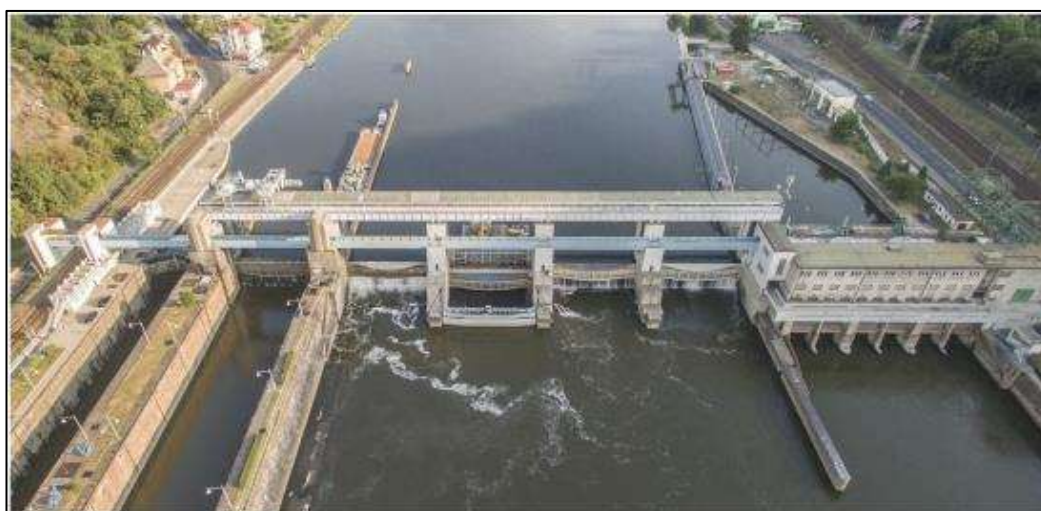
Obrázek 6: Masarykovo zdymadlo Střekov. Vlevo je 2x zdymadlo, uprostřed pohyblivé jezové uzávěry a napravo objekt vodní elektrárny (Nadace pro rozvoj architektury a stavitelství, nedat.).
