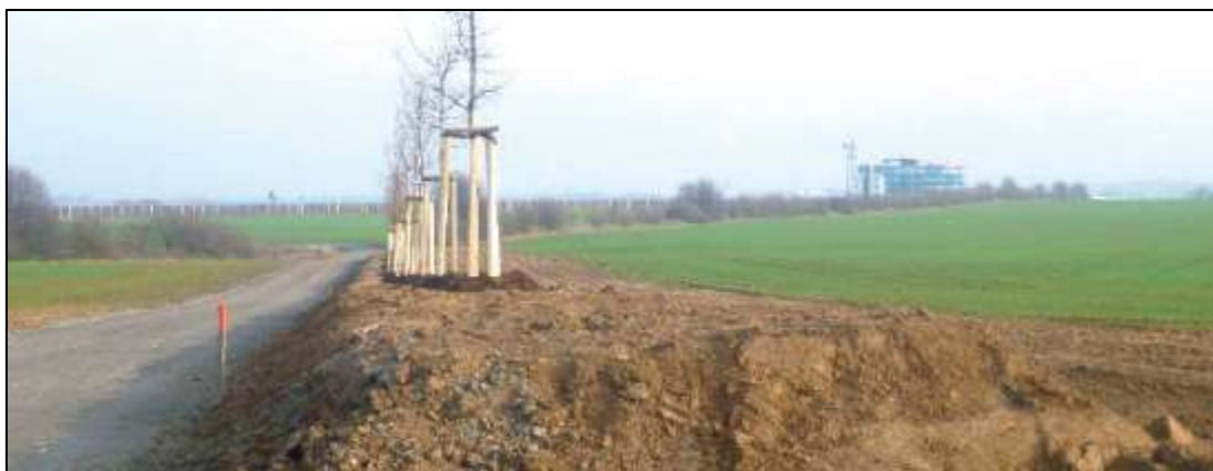
Obrázek 15: Nově vybudovaná ochranná hrázka s vysázenými stromy, které budou doplněné zatravněním. Hrázka chrání přilehlou komunikaci a níže položené pozemky (Státní pozemkový úřad, 2014).
