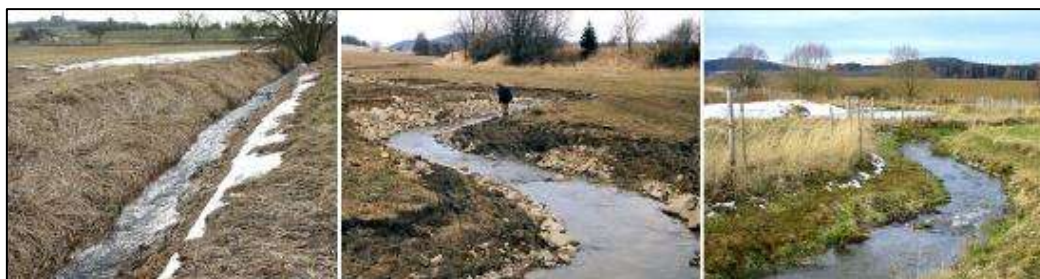
Obrázek 7: Příklad revitalizace vodního toku v extravilánu. Vlevo technicky upravené koryto (hluboké a přímé), uprostřed stav koryta po revitalizaci v roce 2004, napravo vodní koryto v roce 2008 (Just et al., 2020), úprava autor.
