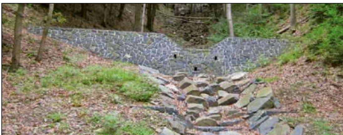
Obrázek 19: Přehrážka z tzv. režného zdiva v horském svahu. Pod přehrážkou je vidět hrubý balvanitý skluz pro tlumení energie dopadající vody (Vokurka a Zlatuška, 2020).
