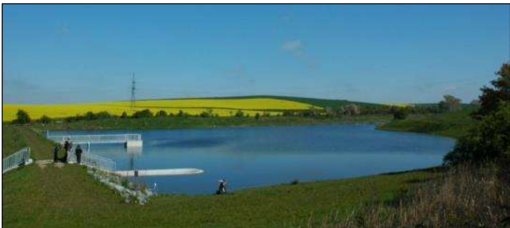
Obrázek 4: Malá vodní nádrž. Vlevo na obrázku je vidět zemní hráz (Výzkumný ústav vodohospodářský, 2018).
