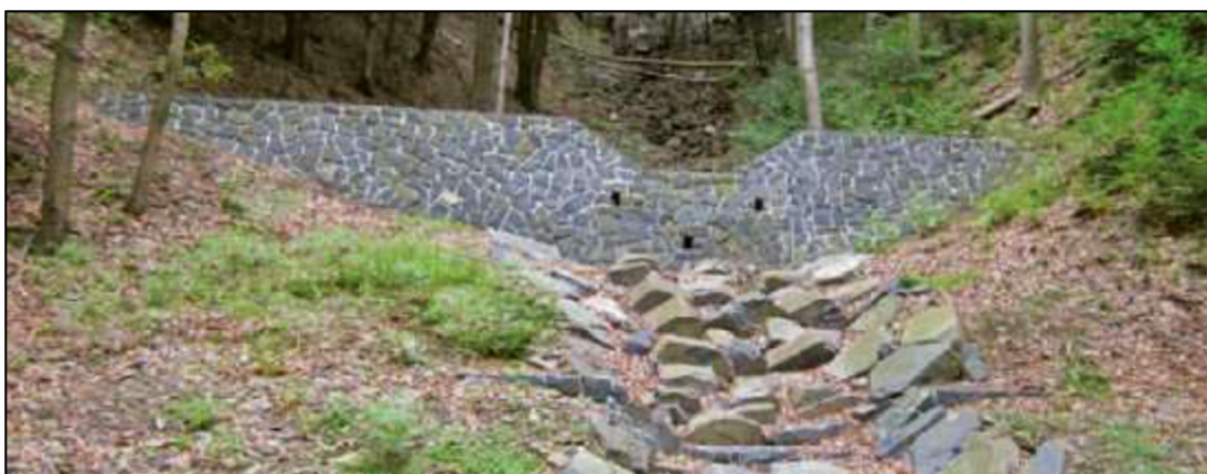
Obrázek 19: Přehrážka z tzv. režného zdiva v horském svahu. Pod přehrážkou je vidět hrubý balvanitý skluz pro tlumení energie dopadající vody (Vokurka a Zlatuška, 2020).
