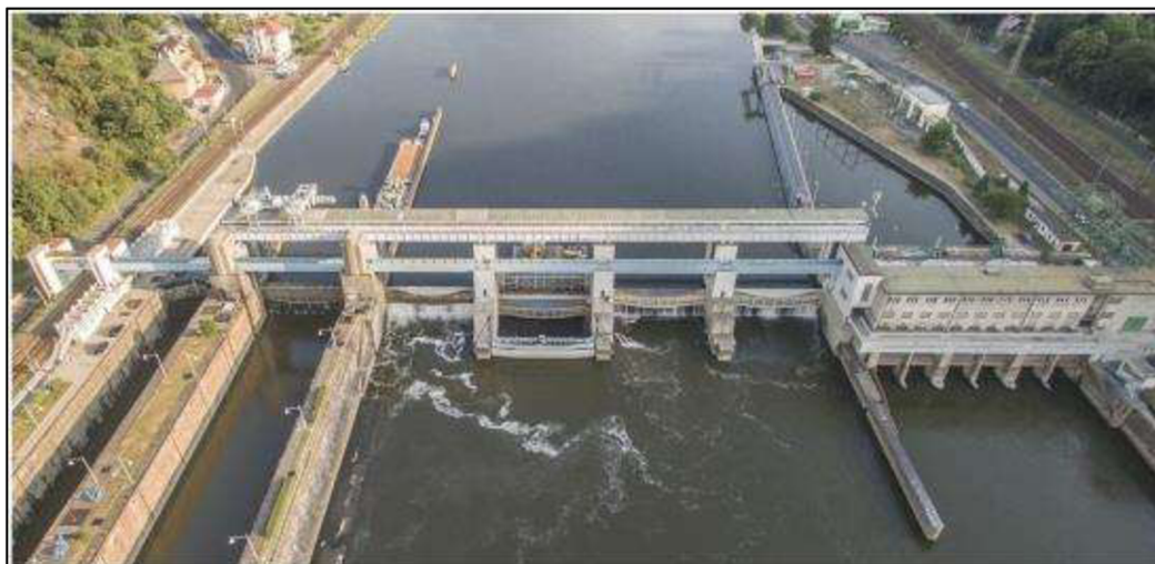
Obrázek 6: Masarykovo zdymadlo Střekov. Vlevo je 2x zdymadlo, uprostřed pohyblivé jezové uzávěry a napravo objekt vodní elektrárny (Nadace pro rozvoj architektury a stavitelství, nedat.).
