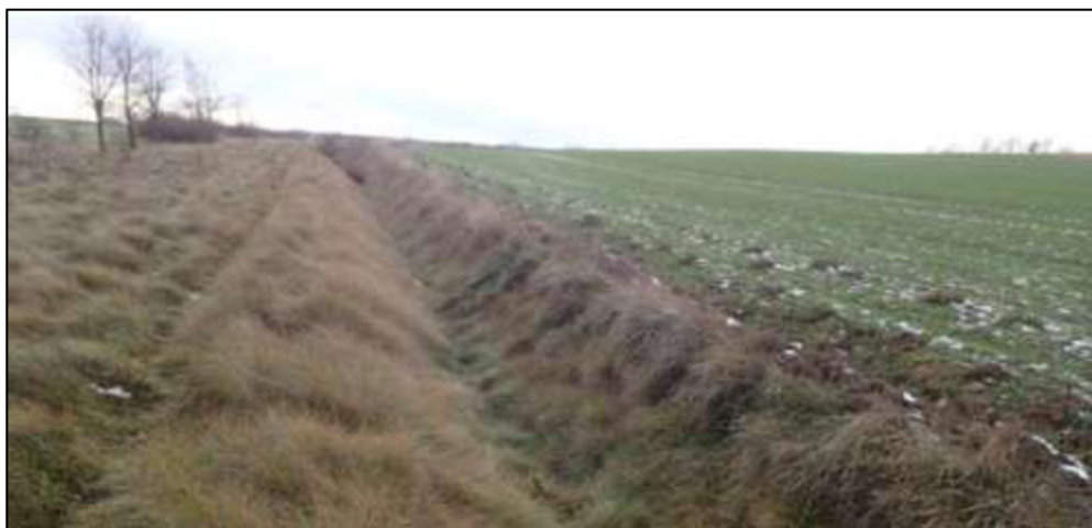
Obrázek 13: Zatravněný svodný příkop s doprovodným travním pásem vlevo (Výzkumný ústav vodohospodářský, 2018)
