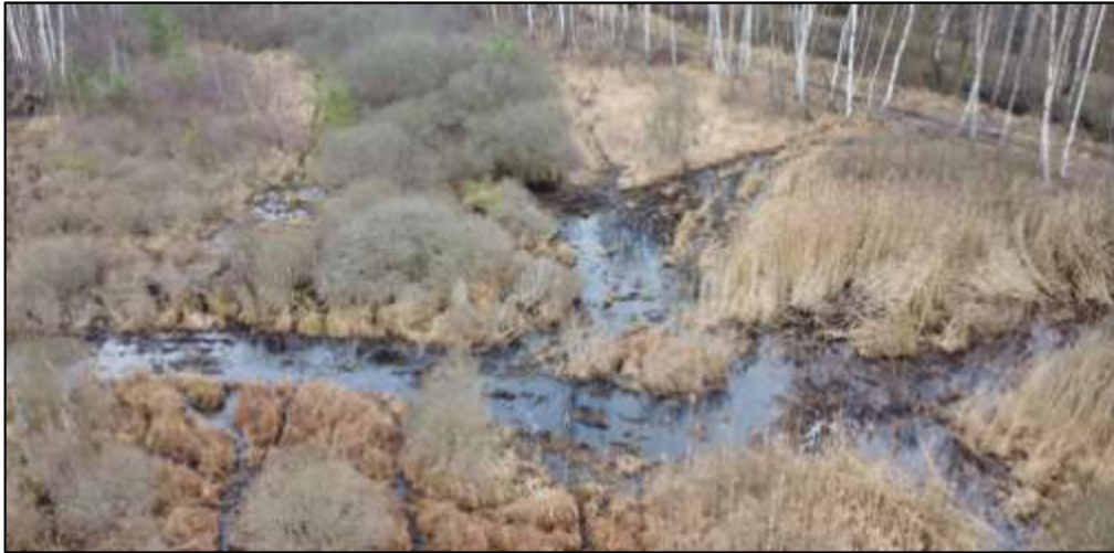
Obrázek 21: Obnovený mokřad, který postupně vysychal a zarůstal náletovými dřevinami. Opětovného zavodnění bylo dosaženo zaslepením odvodňovacích kanálů a jejich přehrazením dřevěnými přehrážkami v počtu 43 ks (Lesy ČR, 2022).
