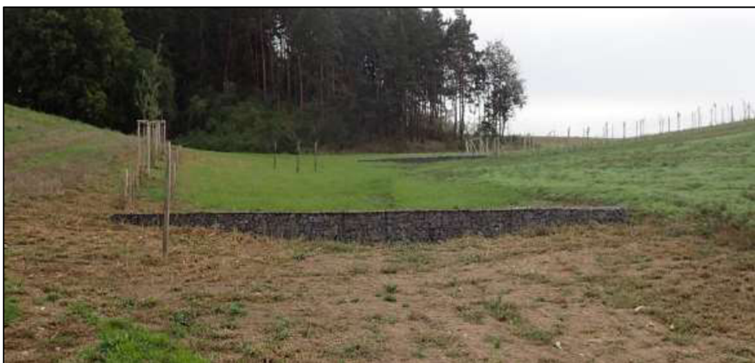
Obrázek 16: Dvě gabionové přehrážky vybudované na zatravněné údolnici (Výzkumný ústav vodohospodářský, 2018).
