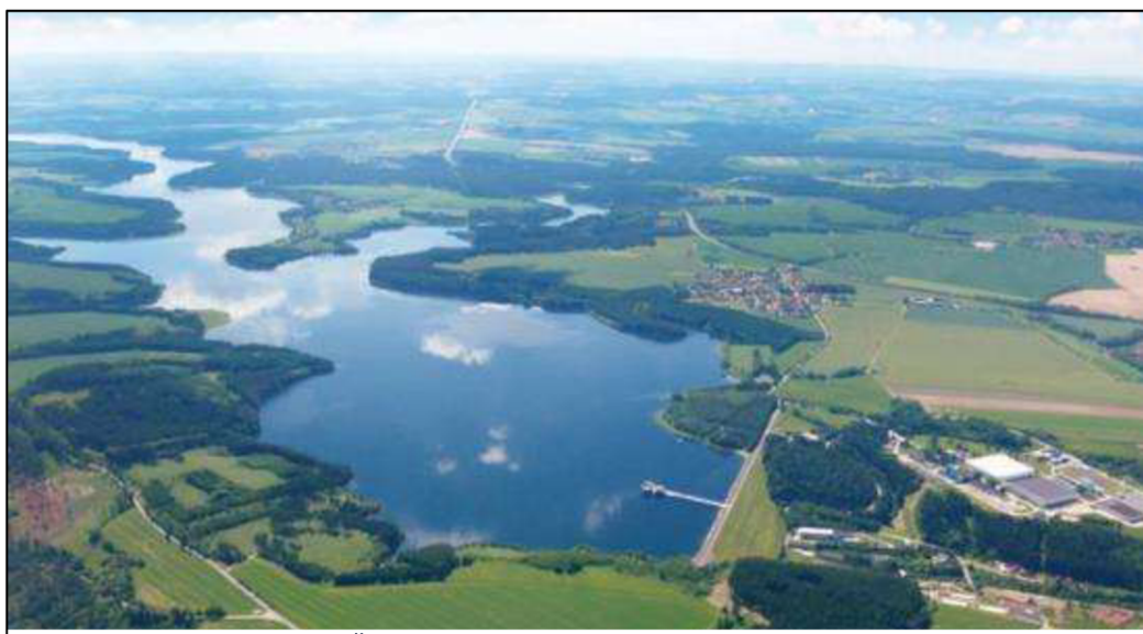
Obrázek 5: Pohled na vodní dílo Švihov. V pravé spodní části obrázku je vidět zemní hráz a zcela vpravo úpravna vody (Liška et al., 2016).
