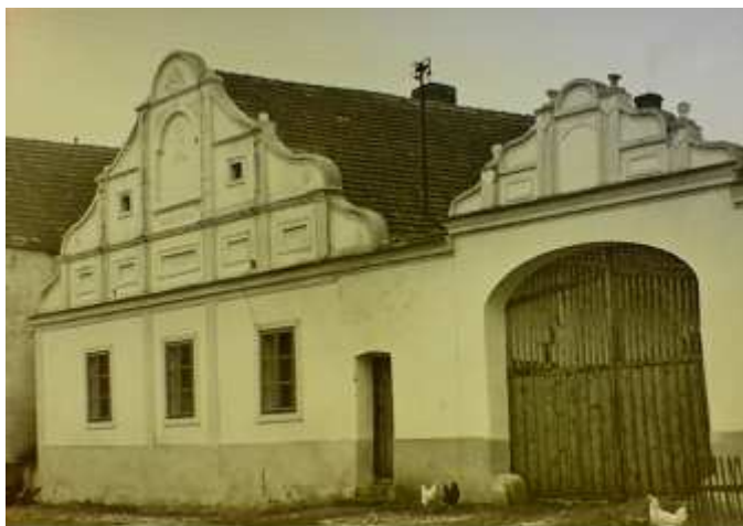
Fotografie dokumentující stav budovy po opravě v roce 1972
