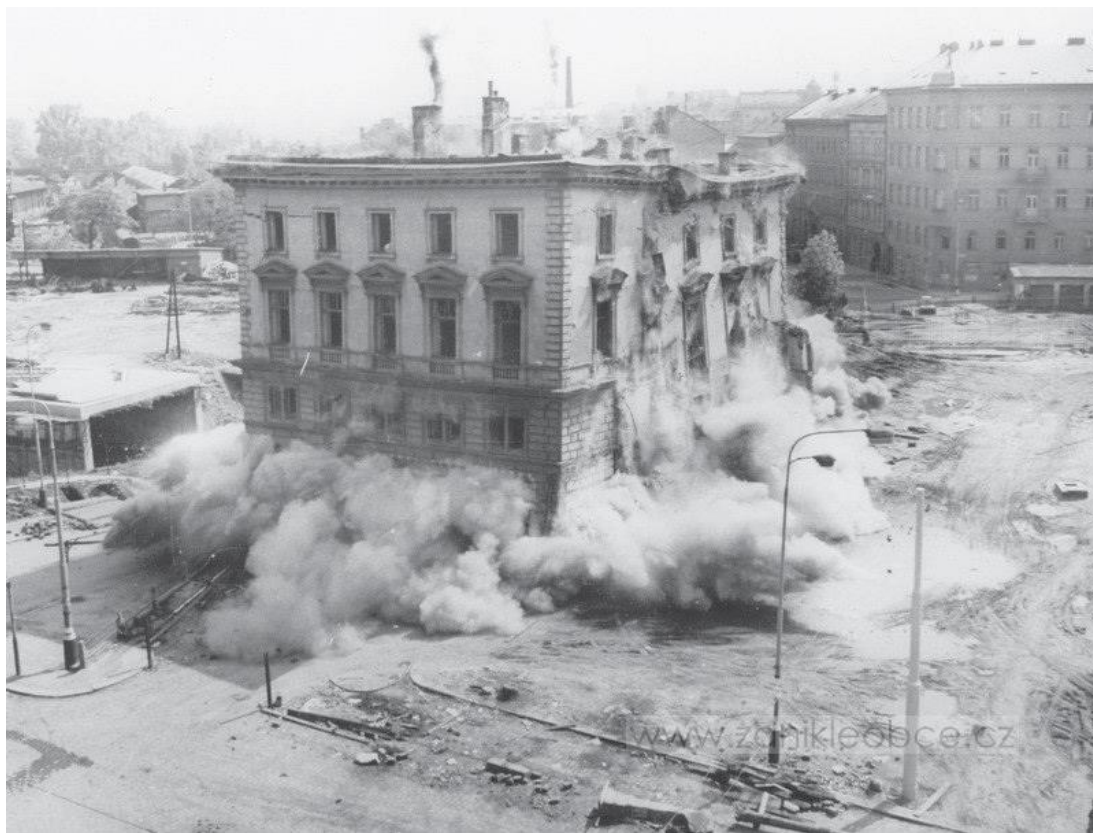
Demolice severního traktu budovy nádraží Praha – Těšnov, zleva již prostor zaplňuje těleso magistrály
