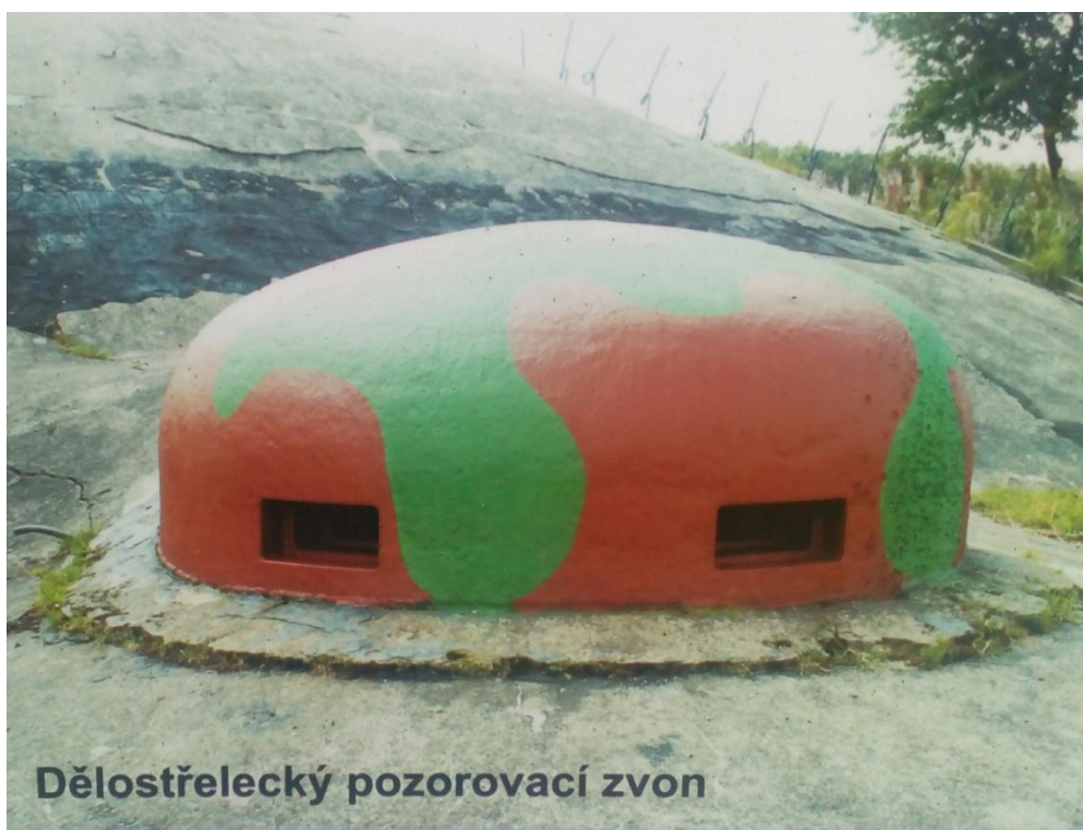
Příloha 17: Dělostřelecký pozorovací zvon pěchotního srubu "Teta" Zdroj: Kminiaková, 2017
