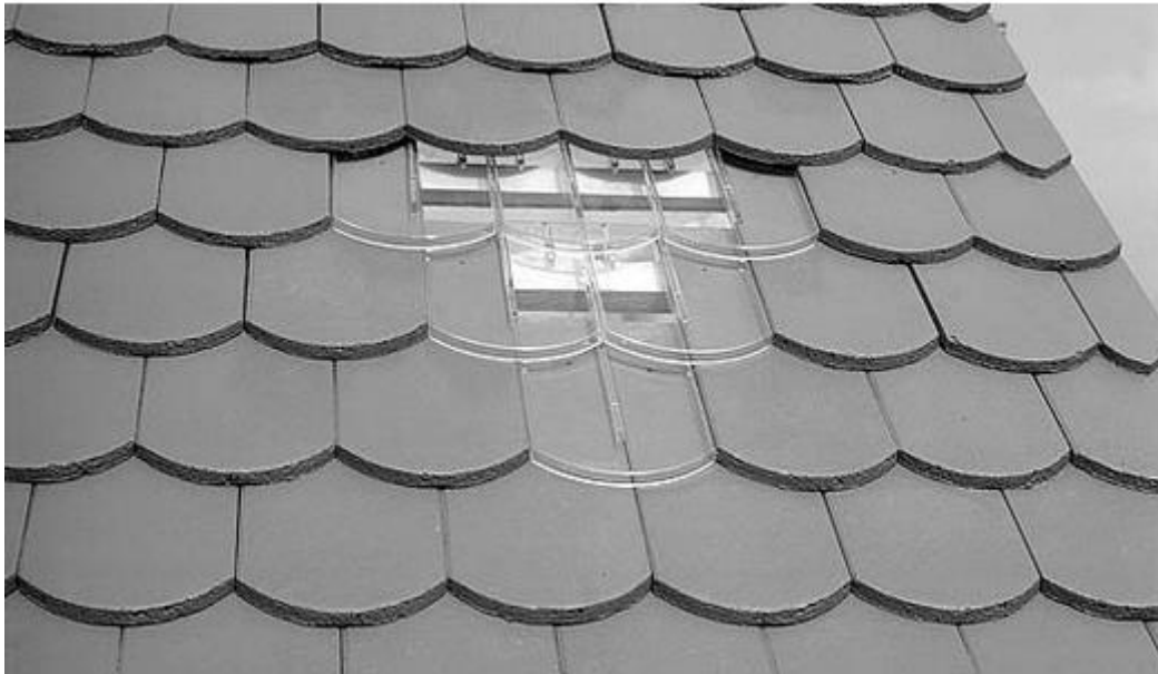
Obrázek 18: Možnost využití recyklátu na výrobu střešní krytiny [28]
