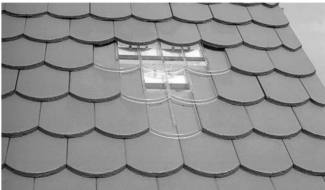
Obrázek 18: Možnost využití recyklátu na výrobu střešní krytiny [28]
