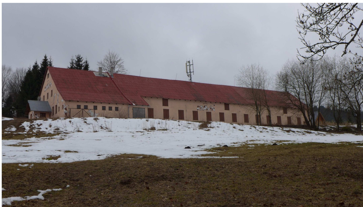
Příloha č. 2: Aktuální podoba objektu bývalého kravína v Bedřichově
