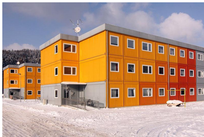
Obr. 13: Kontejnerové bytové domy Vsetín (2006)
