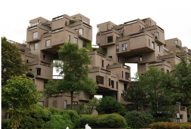
Obr. 9: Modulková stavba Habitat 67
