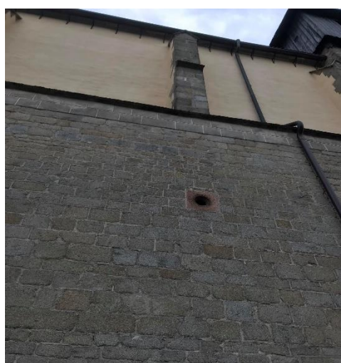
Obr.33 Zazděná okna pod nově upraveným vchodem
