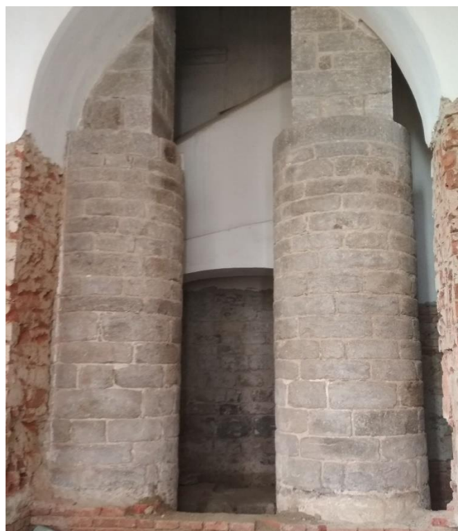
Obr.18 Sloupy z románské věže zasahující do interiéru chrámu
