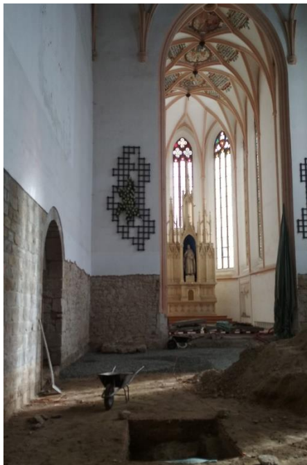
Obr. 25 Pohled na prováděné vykopávky
