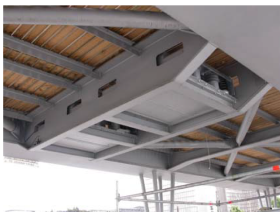
Obr. 2.9 Pohlcovač kmitání na lávce [17]
