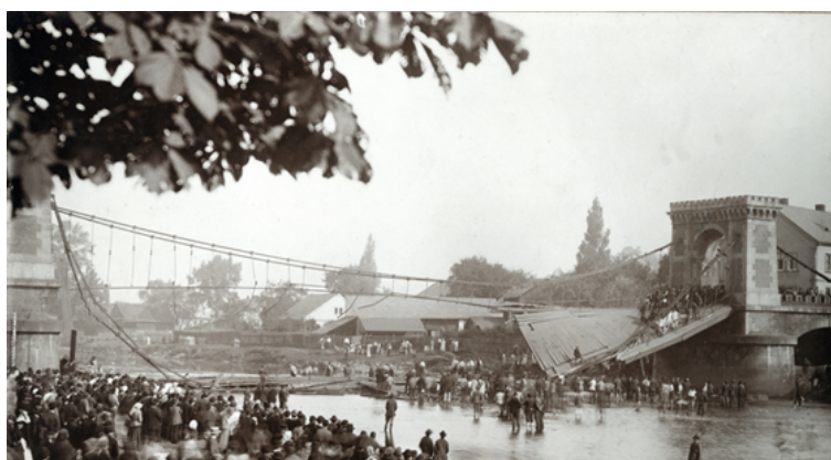
Obr. 1.2 Kolaps Říšského mostu v Ostravě [47]
