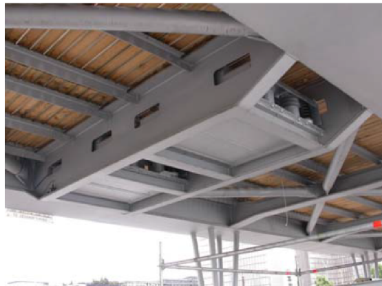
Obr. 2.9 Pohlcovač kmitání na lávce [17]
