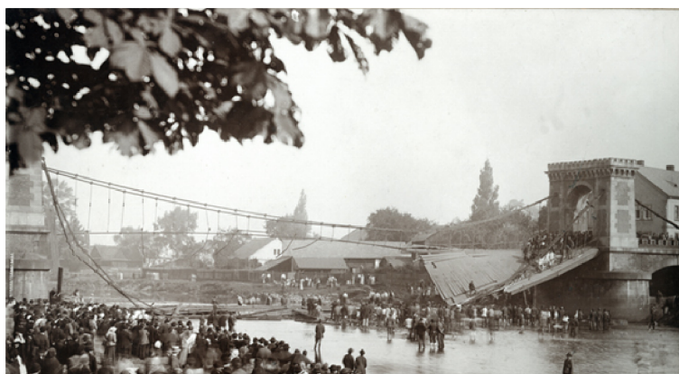
Obr. 1.2 Kolaps Říšského mostu v Ostravě [47]
