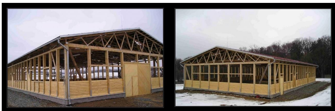
Obr. 30 Otevřená jízďárna Nevekov (Dřevěné konstrukce, s. r. o. 2017)
