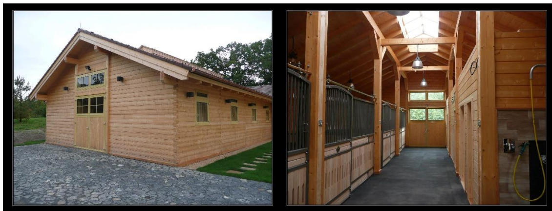
Obr. 28 Stáje pro koně ve Středních Čechách (Jezdecké stavby 2017)
