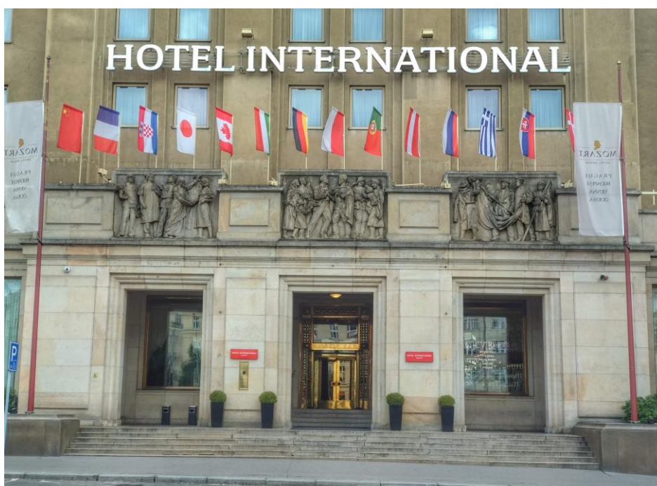
Príloha č. 9: Hotel International, hlavný vstup (foto: archiv autora).
