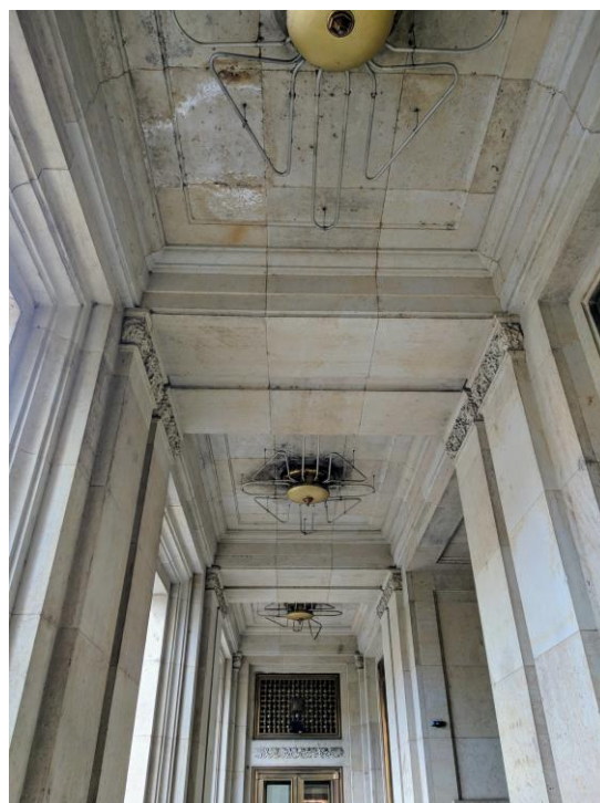
Příloha č. 12: Hotel International, strop portiku nad hlavním vstupem (foto: archiv autora).
