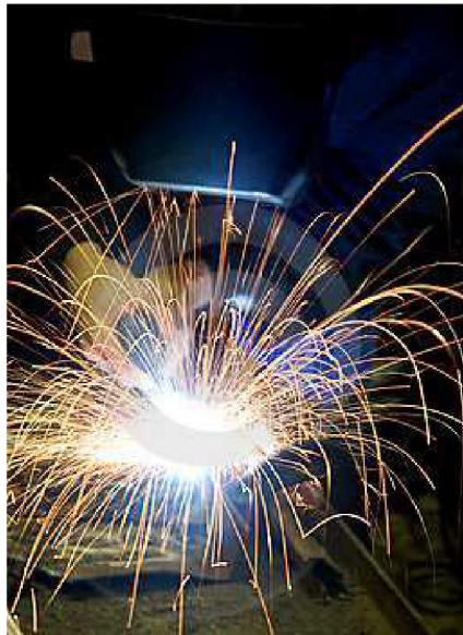
Obr. 5 Svařování v ochranné atmosféře [7].
