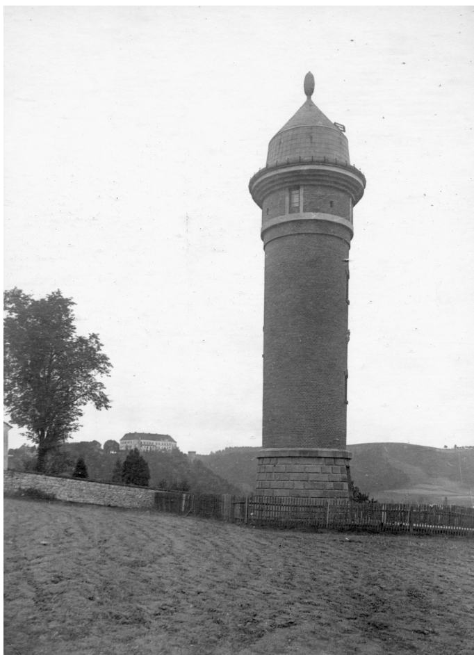
Obr. 4 Odlehčovací věž I. březovského vodovodu v Letovicích 51
