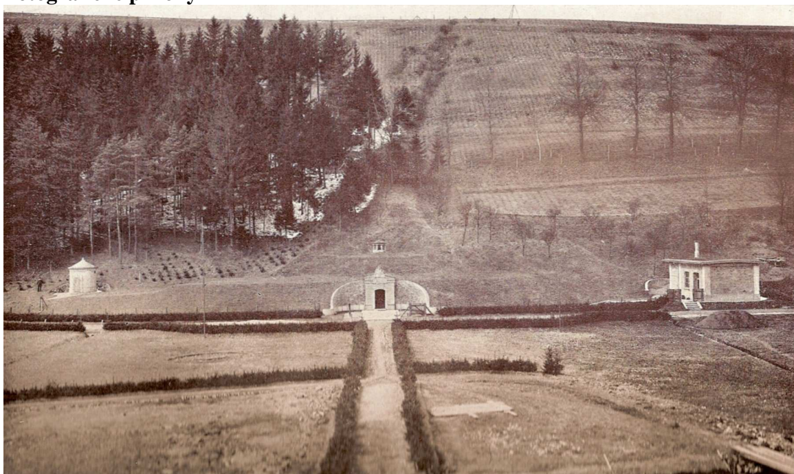
Obr. 3 Vchod do štol v Quellhütten 50
