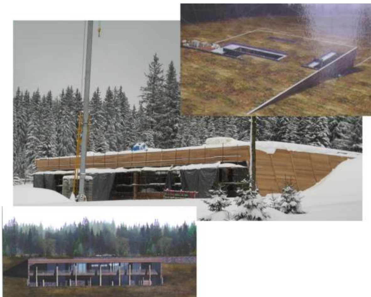
Obr. 35.: Stavba rodinného domu podnikatele Bakaly na Modravě (vlastní archiv)
