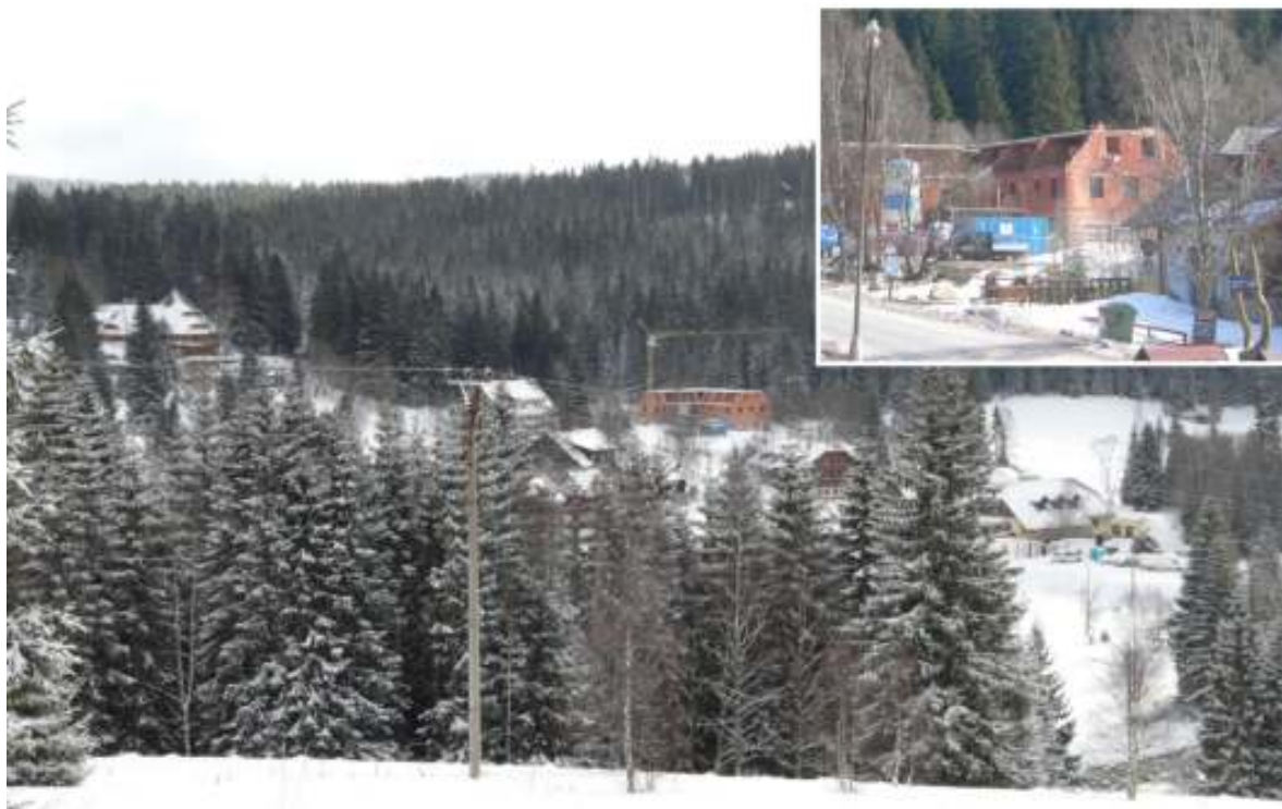
Obr. 33.: Rozestavěný penzion u silnice na Filipovu Hut' (vlastní archiv)
