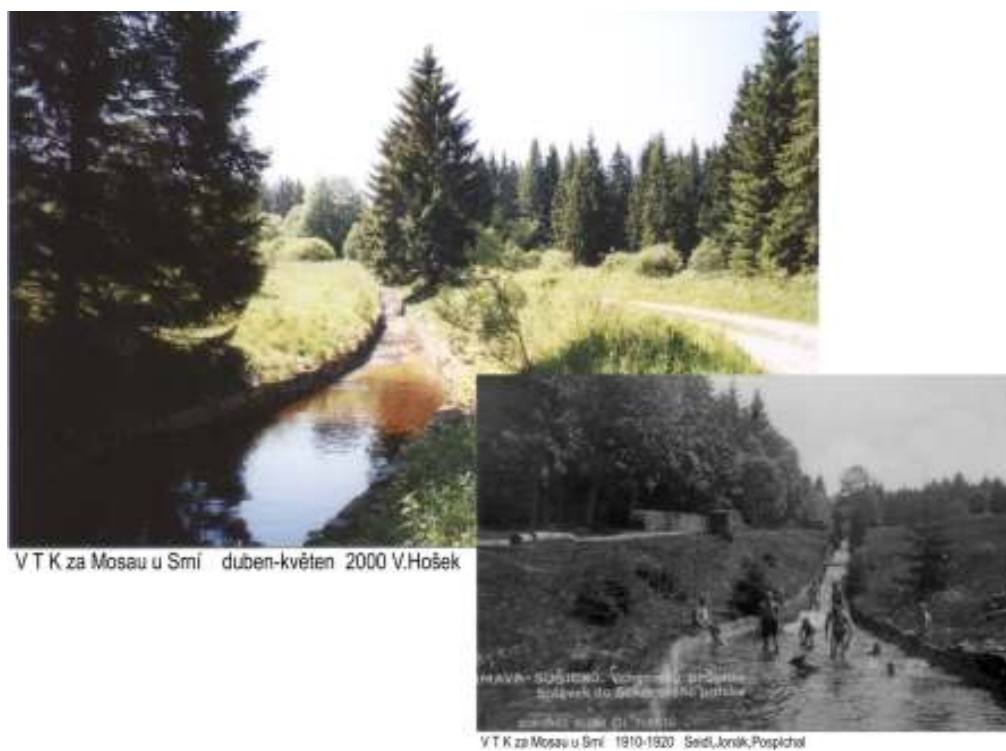
Obr. 22.: Vchynicko-Tetovský plavební kanál a jeho podoba z počátku 20. stol. (vlastní archiv – jména původních autorů jsou umístěna ve snímcích)
