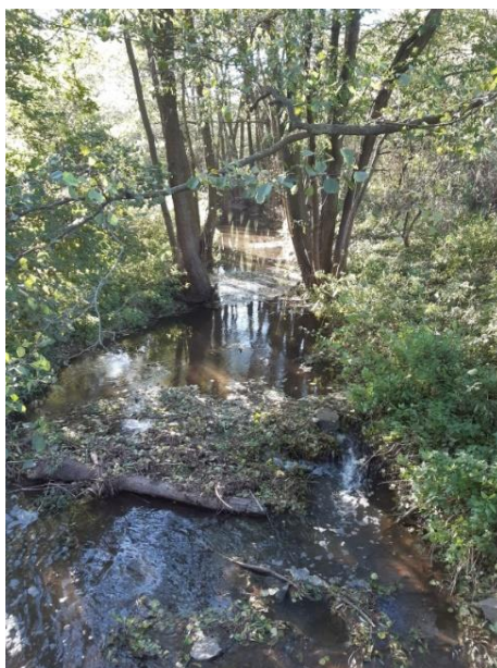
Obrázek č. 42 částečně revitalizovaný úsek
