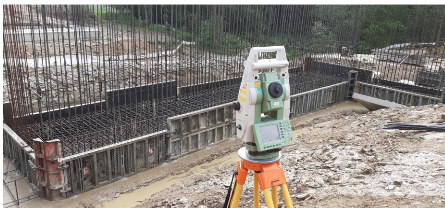
Obrázek 1.18: Urovnávání bednění OP2 na objektu SO212 (vlastní)
