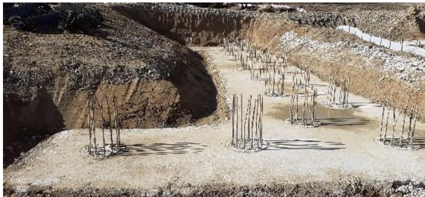
Obrázek 1.3: Podkladní beton s očištěnými pilotami na objektu SO 212 (vlastní)
