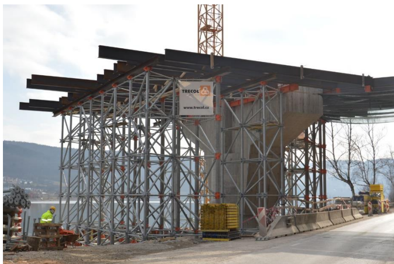
Obrázek 1.24: Pevná skruž se stojkami a nosníky ( http://www.lkmconsult.cz/ )
