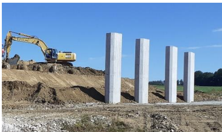
Obrázek 1.6: Pilíře na objektu SO 216 (vlastní)
