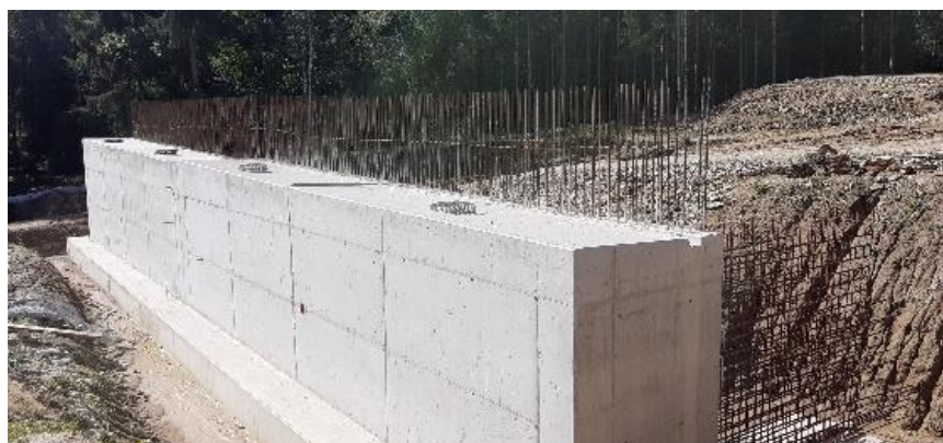
Obrázek 1.5: Základ a dřík opěry na objektu SO212 (vlastní)
