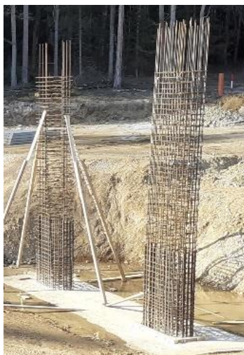
Obrázek 1.4: Svázaná betonářská výztuž na objektu SO 213 (vlastní)
