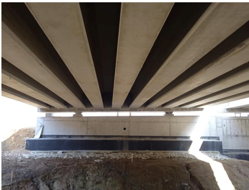
Obrázek 1.25: Nosná konstrukce objektu SO212 (vlastní)
