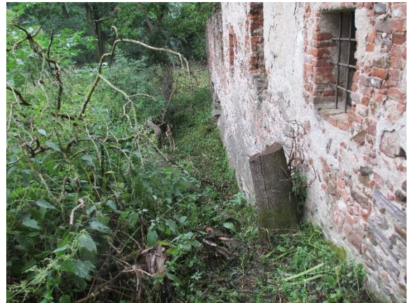
Obr. 3.3 Průsek okolo budovy
