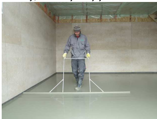
Obrázek 9-8: Nivelace anhydritu
