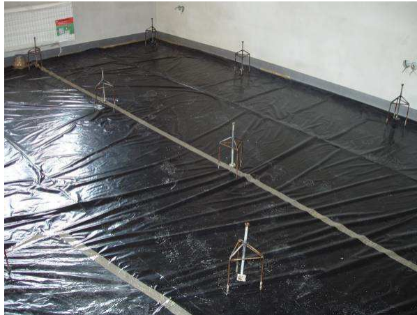
Obrázek 9-5: Rozestavění nivelačních trojnožek
