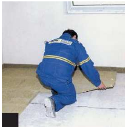
Obrázek 9-3: Pokládka izolačních desek
