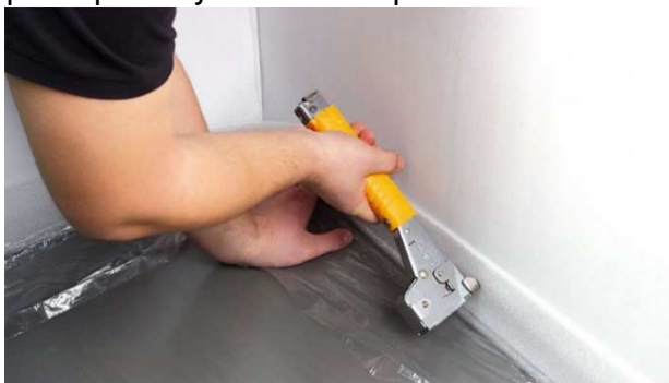
Obrázek 9-2: Pokládka obvodové dilatační pásky
